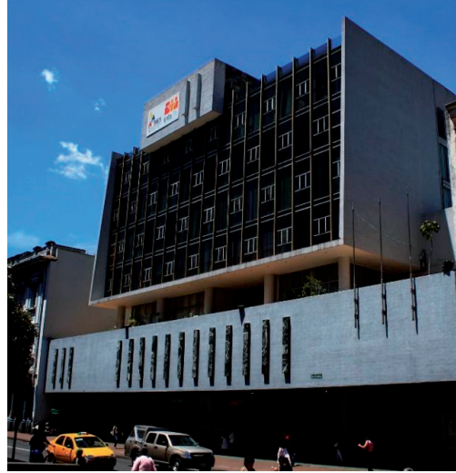
Figura 11: Fachada frontal del Banco de Préstamos.
