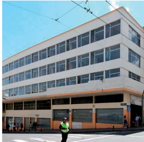
Figura 7: Vista de la fachada principal del Antiguo Registro Civil sobre la calle Mejía. Fuente: MIDUVI, 2013
