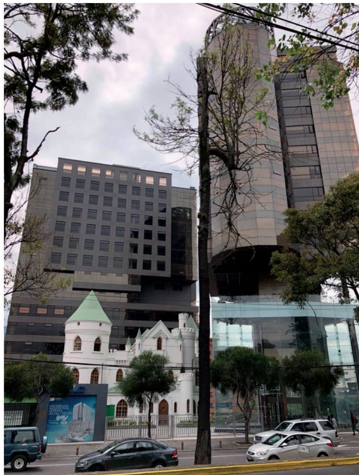
Figura 1: Conjunto arquitectónico ubicado en la Castillo Larrea, 12 de Octubre y Baquerizo Moreno, Quito. Estado actual
