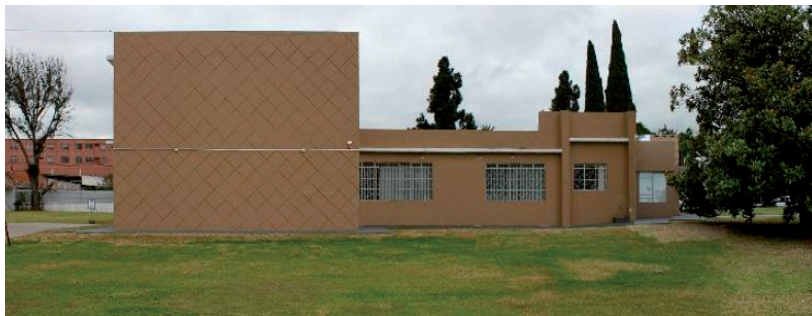
Figura 12: Imagen de la elevación rectificada mediante Onsite Photo y unificada mediante Adobe Photoshop Fuente: Autores, 2017
