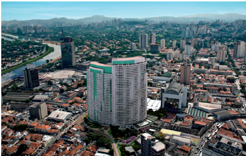
Figura 2: Uno de los nuevos edificios construidos revelando su impacto en el paisaje
