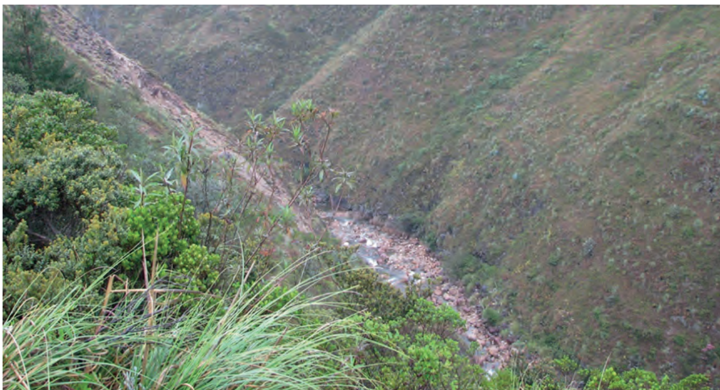
Sección Dumapara – Uduzhapa. Segmento Ñamarín, camino con muros laterales
