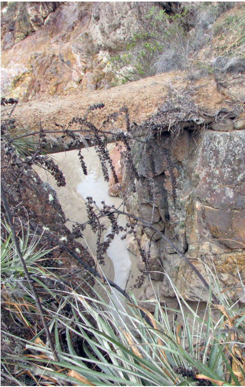
Sección Uduzhapa – Cuzcudoma, basamento de puente en río Oña
