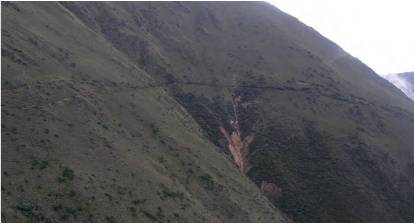
Subtramo Tomebamba – Puerto de Yaguachi. Sección Patul – Sanagüín
