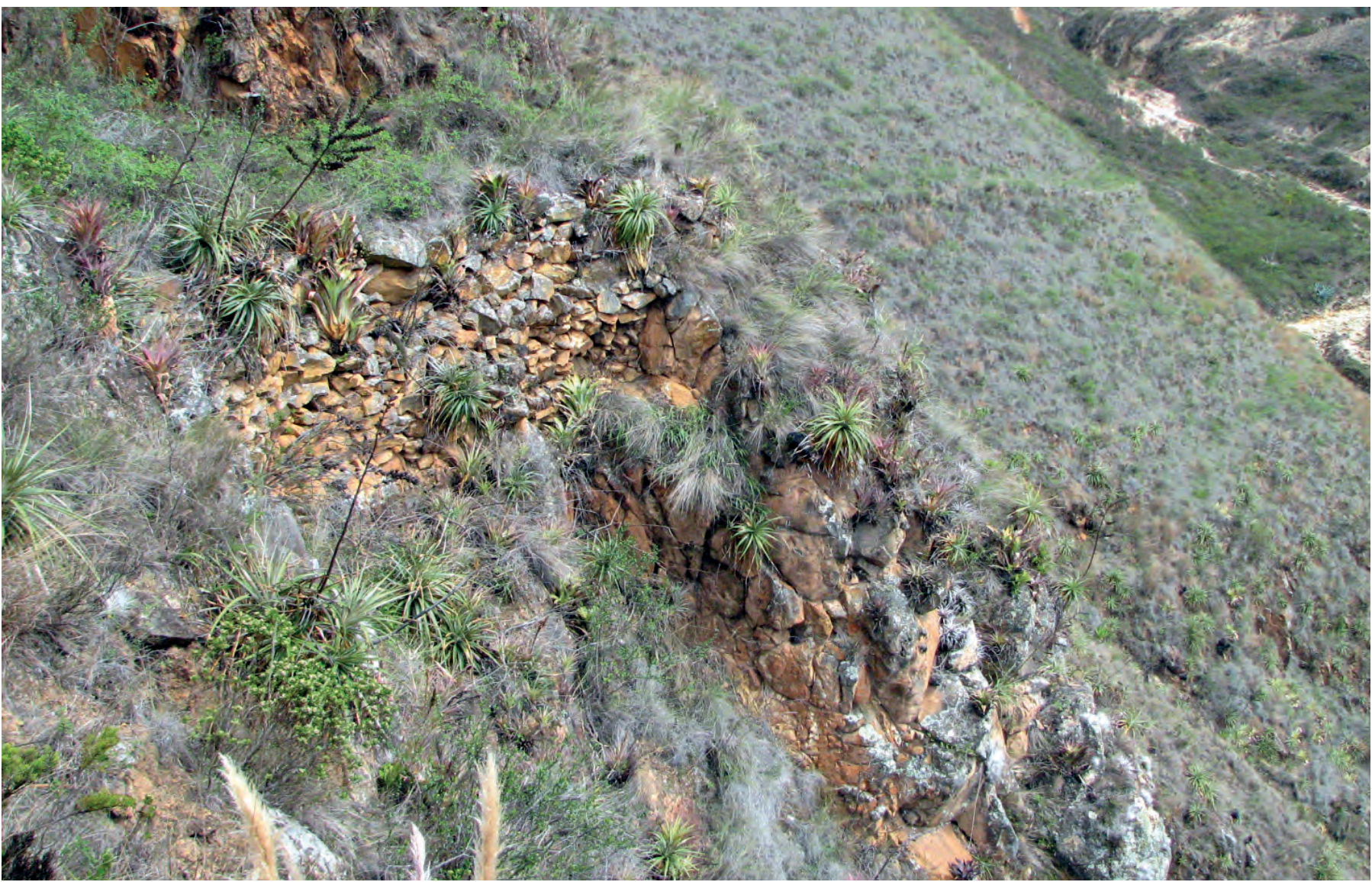
Sección Uduzhapa – Cuzcudoma. Camino y muro lateral de 3m de alto en el cerro Zhuñín
