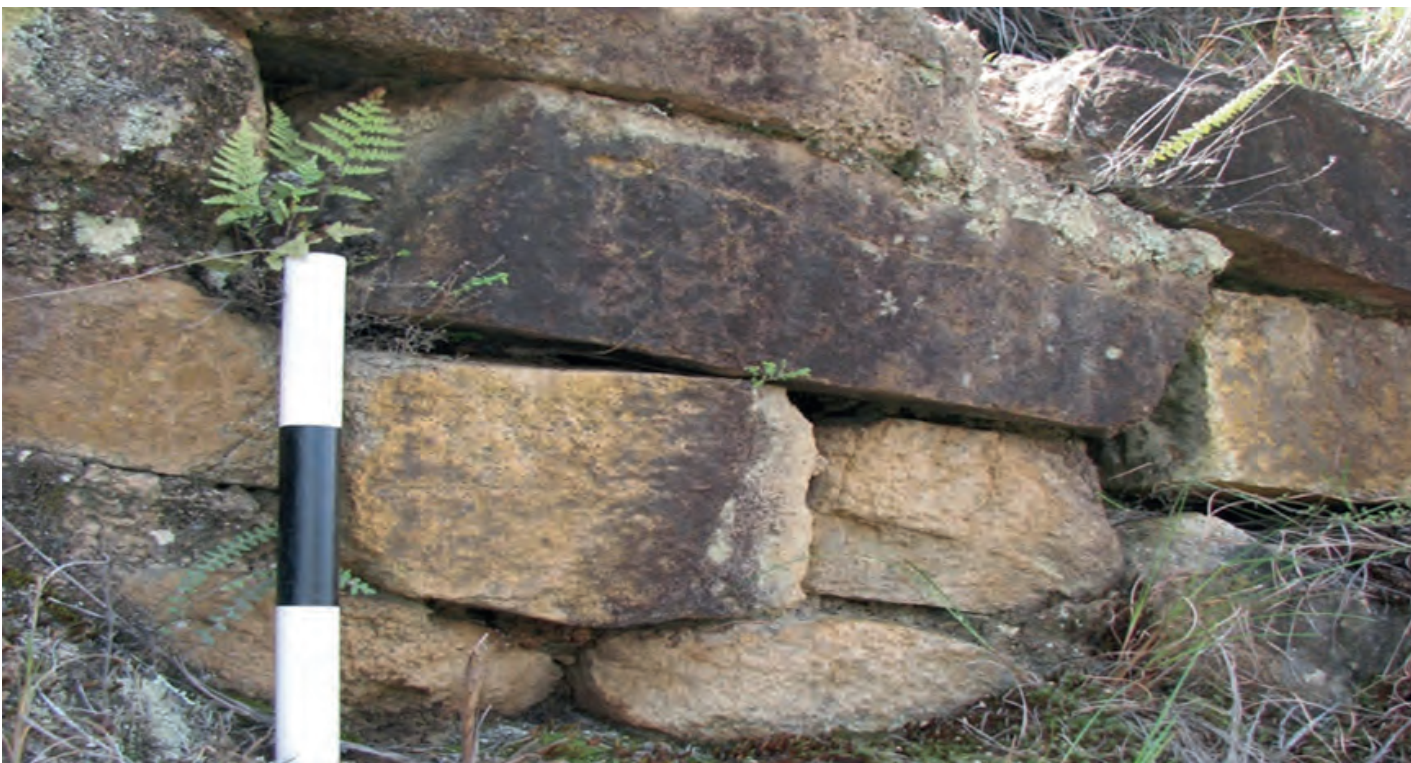
Sección Dumapara – Uduzhapa. Segmento Ñamarín, muros laterales del camino
