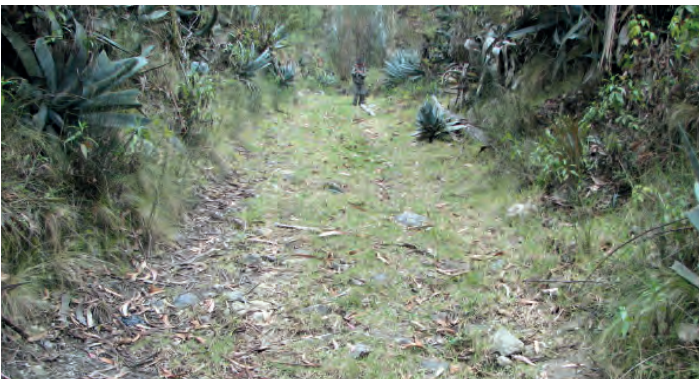
Sección La Raya – Ricaurte. Segmento de camino y muros laterales, El Guabo
