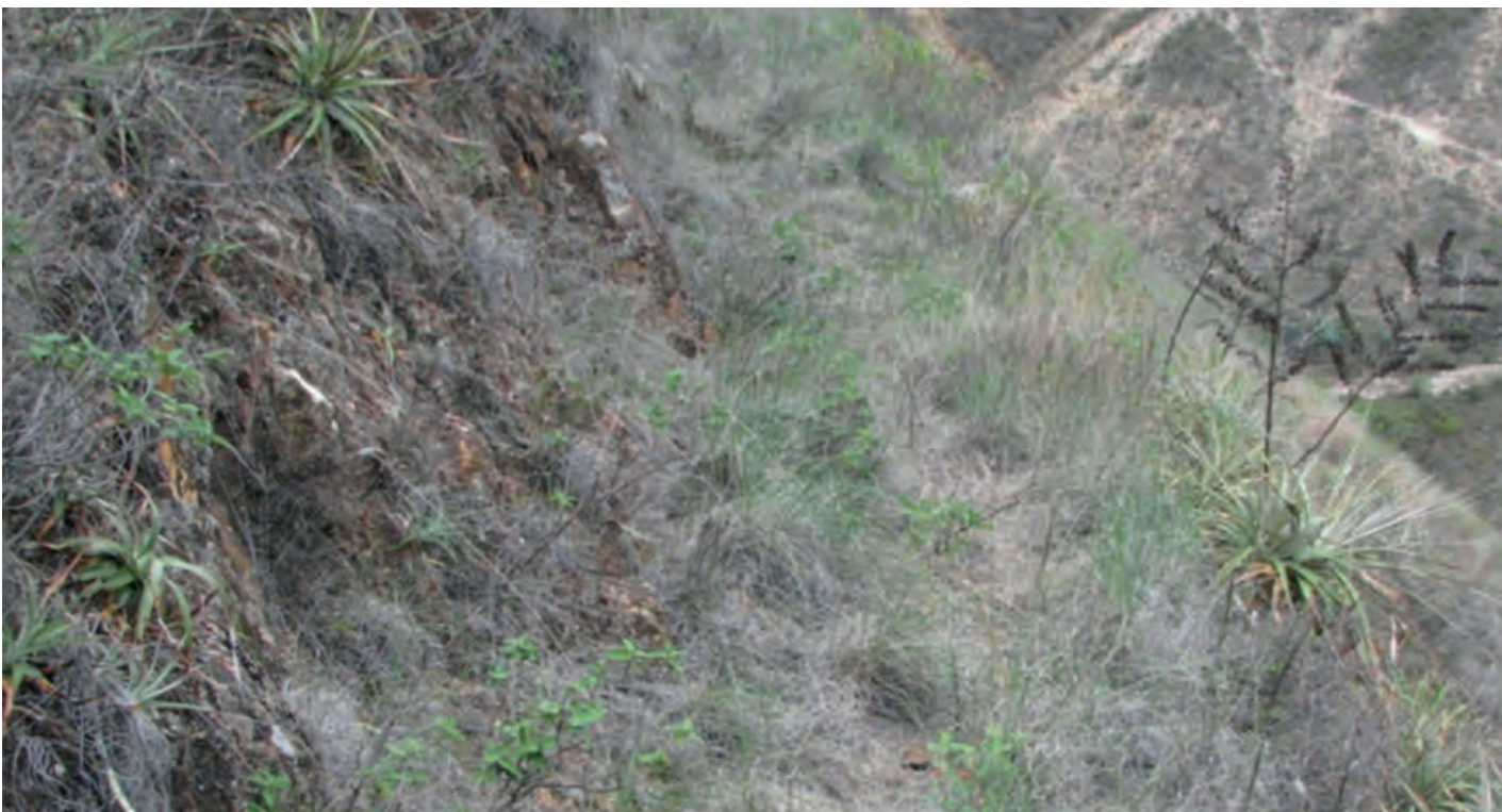
Sección Udulzhapa – Cuzcudoma. Huella de camino de 1 m de ancho. Corte de montaña y muros laterales en el cerro Zhuñín
