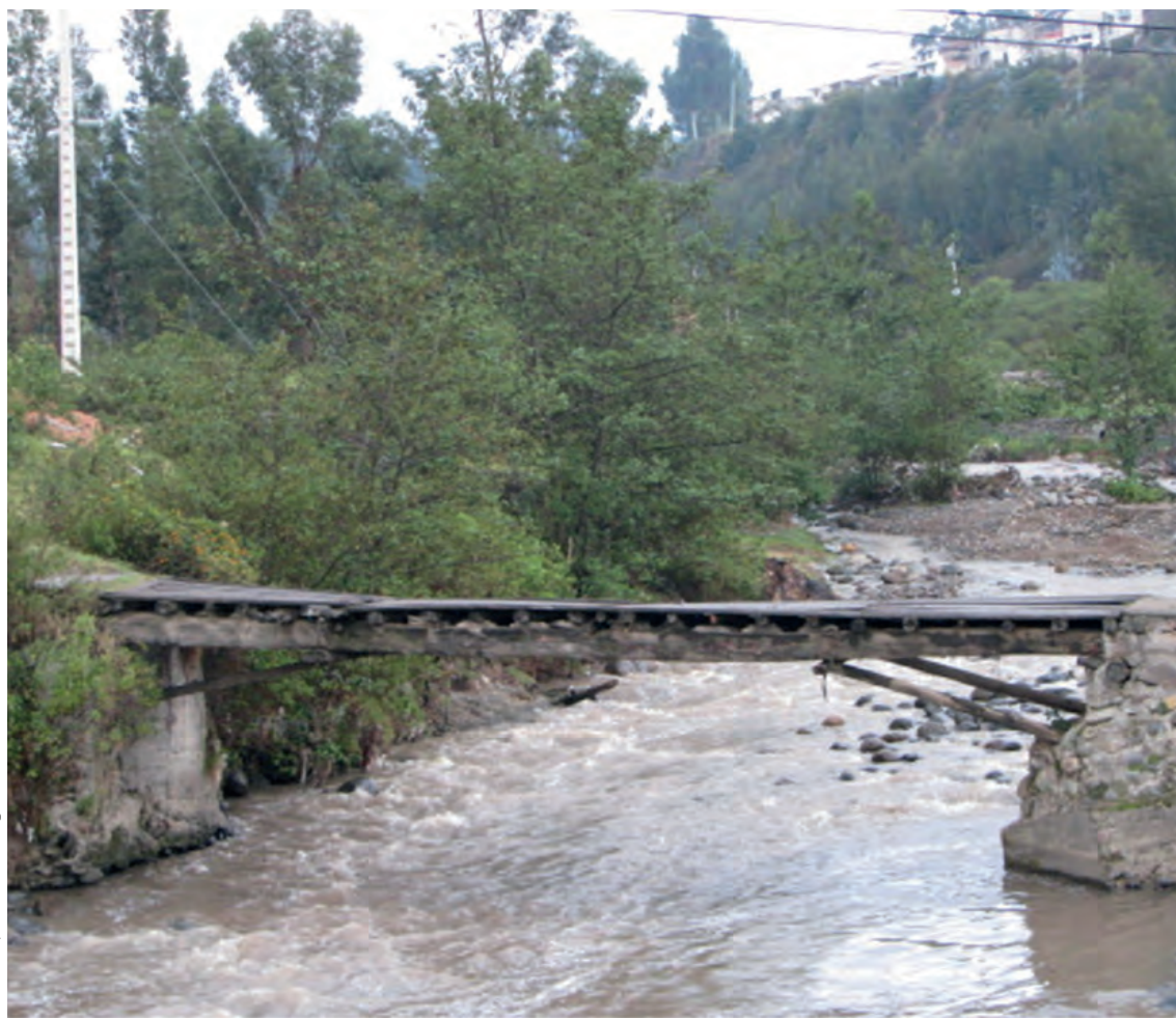
Sección Ricaurte – Tomebamba, puente sobre el río Machángara
