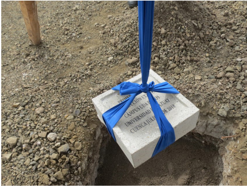
Figura 76 Colocación primera piedra.
