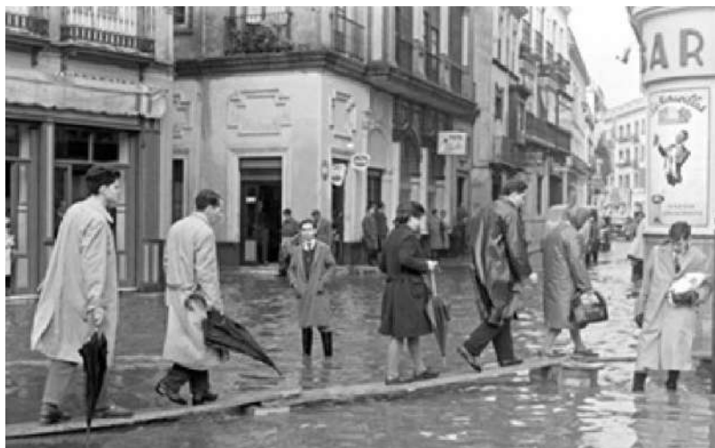
Figura 2: Inundación por el desbordamiento del río Tamarquillo en 1961
