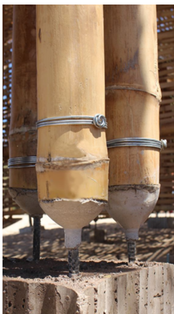
Figura 29: Anclaje mediante varillas de acero.
