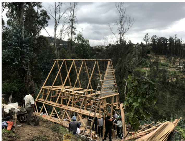
Figura 33: Construcción del Triángulo de las Verduras. Nota. Tomado de Cómo construir un invernadero de bajo presupuesto con un triángulo de bambú, madera y plástico por Natura Futura Arquitectura (2008).
