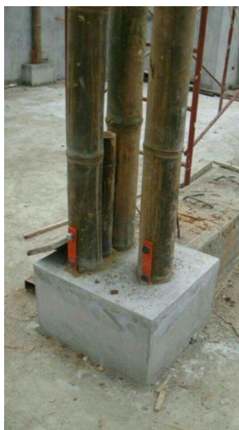
Figura 30: Anclaje mediante pletinas de acero.
