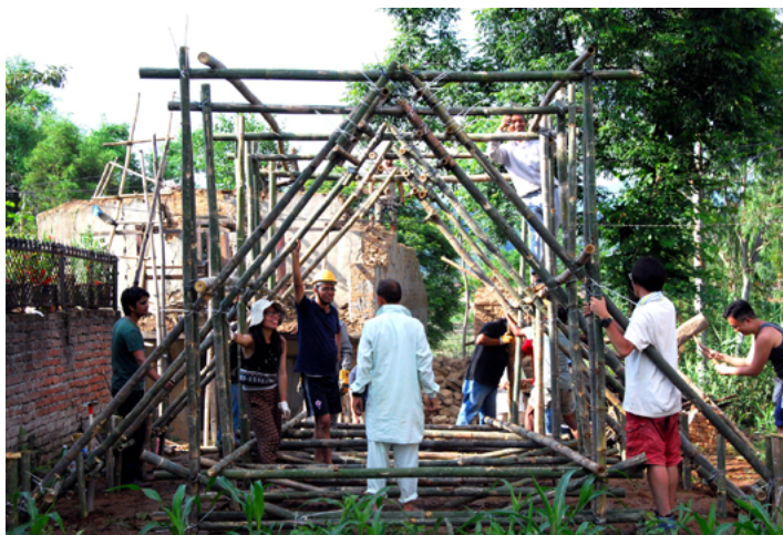
Figura 16: Proceso de construcción de refugio temporal en Nepal. Nota. Tomado de ArchDaily – Refugio Temporal en Nepal por Charles Lai (2015).
