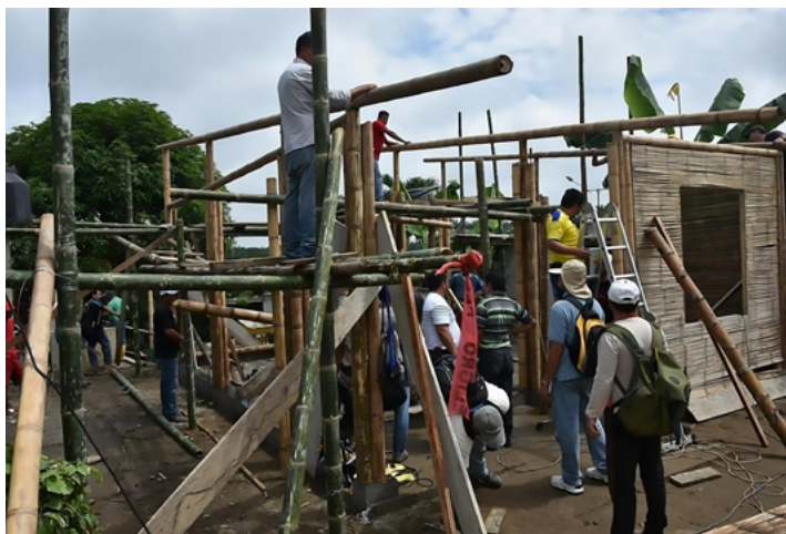
Figura 24: Construcción en caña guadua de vivienda en la provincia de Santo Domingo. Nota. Tomado de Construcción en caña guadua de vivienda en la provincia de Santo Domingo por EIDiario.ec
