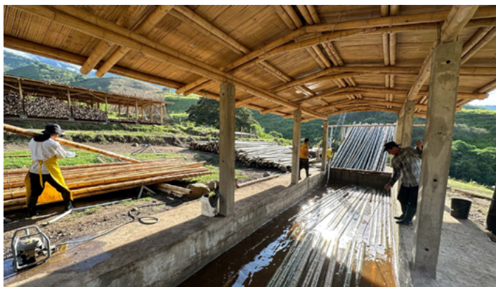
Figura 27: Preservación de la caña guadua por inmersión. Nota. Tomado de Proceso de Producción de Postes de Guadua Bambú por Guadua Bamboo (2017).
