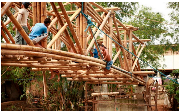
Figura 28: Construcción de puente de caña guadua.
