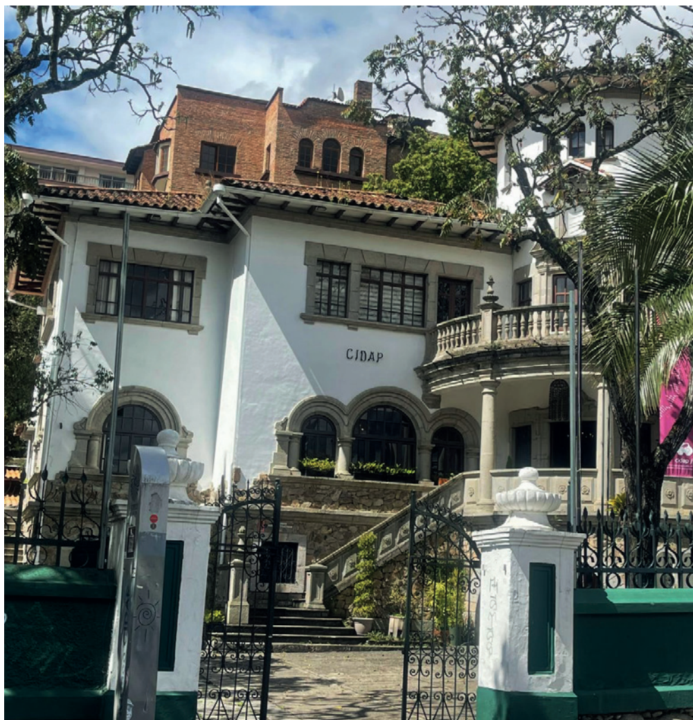
► Figura 31 Edificio del CIDAP.
