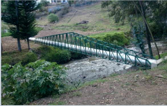
◀ Figura 135 Paso elevado, tubería de agua potable en Rumihurco, Río Burgay, en Javier Loyola, Azogues 2015. Nota: Fotografías proporcionadas por la empresa Everap.
