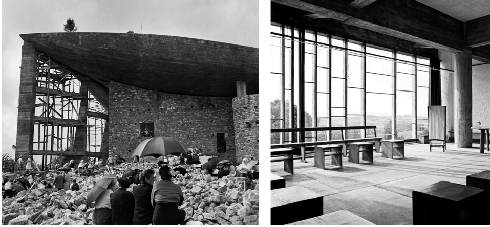
Figura 68. El motivo formal del andamiaje empleado en la construcción de la capilla de Notre-Dame du Haut, en 1953, reaparece en los ondulatoires del convento de La Tourette, realizados entre 1956 y 1959.
