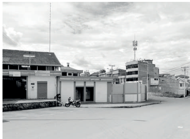
Estado actual Mercado 27 de Febrero
