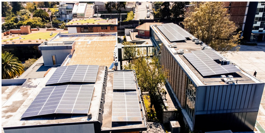
Infraestructura de paneles solares en la Universidad.
