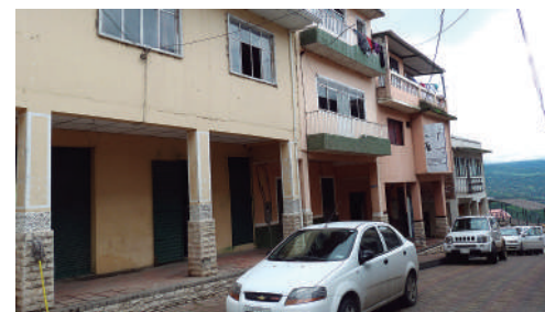
Año 2016 Estado Actual: Sustituida
