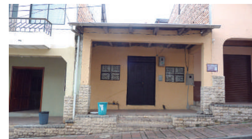
Año 2016 Estado Actual: Sustituida
