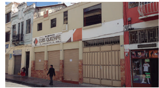
Año 2016 Estado Actual: Sustituida
