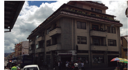
Año 2016 Estado Actual: Sustituida
