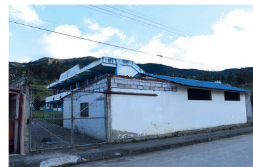
Año 2016 Estado Actual: Sustituida
