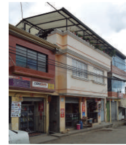
Año 2016 Estado Actual: Sustituida
