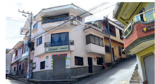
Año 2016 Estado Actual: Sustituida
