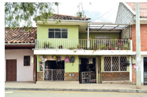
Año 2016 Estado Actual: Sustituida
