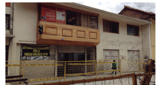
Año 2016 Estado Actual: Sustituido
