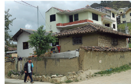
Año 2016 Estado Actual: Sustituida
