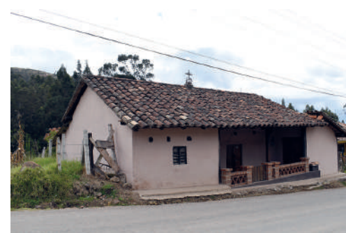
Año 2016 Estado Actual: Sustituida
