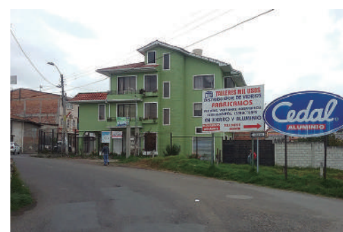
Año 2016 Estado Actual: Sustituida
