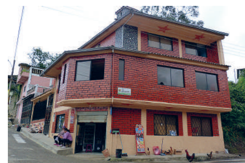
Año 2016 Estado Actual: Sustituido
