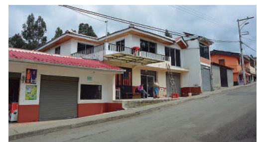
Año 2016 Estado Actual: Sustituida
