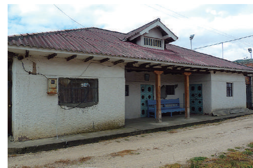
Año 2016 Estado Actual: Sustituida
