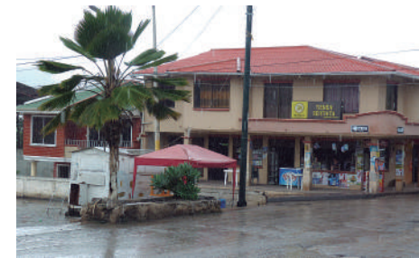
Año 2016 Estado Actual: Sustituida
