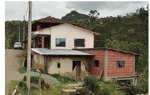
Año 2016 Estado Actual: Sustituida
