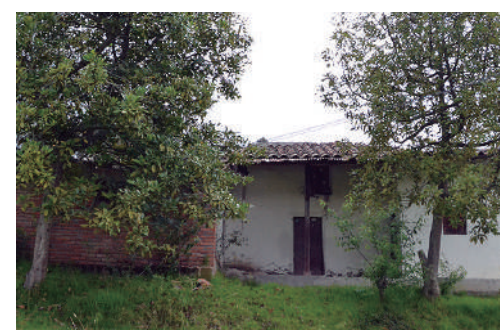
Año 2016 Estado Actual: Sustituida
