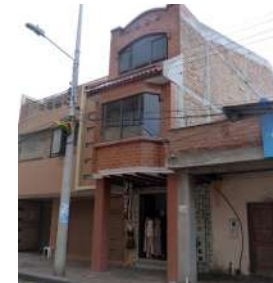
Año 2016 Estado Actual: Sustituida
