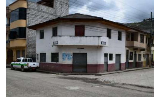
Año 2016 Estado Actual: Sustituida
