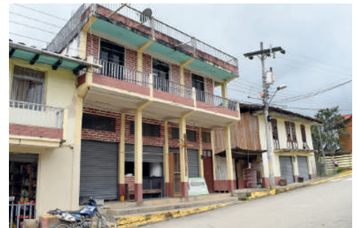
Año 2016 Estado Actual: Sustituida
