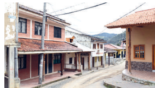
Año 2016 Estado Actual: Sustituido
