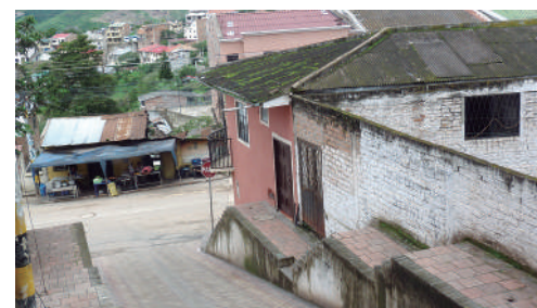
Año 2016 Estado Actual: Sustituida
