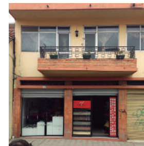
Año 2016 Estado Actual: Sustituida
