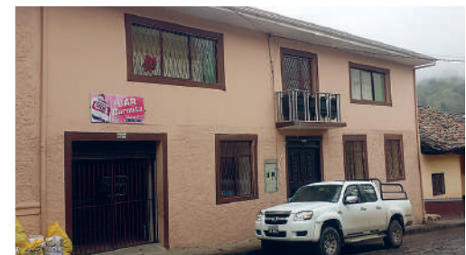
Año 2016 Estado Actual: Sustituida
