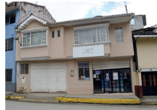
Año 2016 Estado Actual: Sustituida
