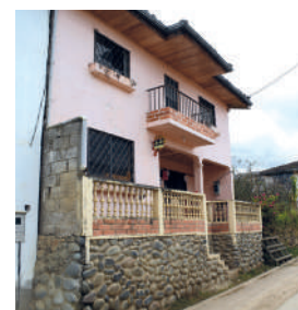
Año 2016 Estado Actual: Sustituida
