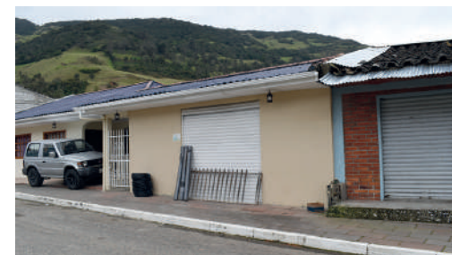
Año 2016 Estado Actual: Sustituido
