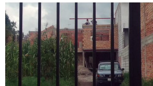
Año 2016 Estado Actual: Sustituida
