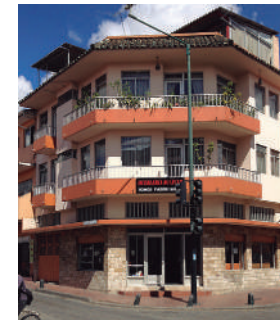
Año 2016 Estado Actual: Sustituida
