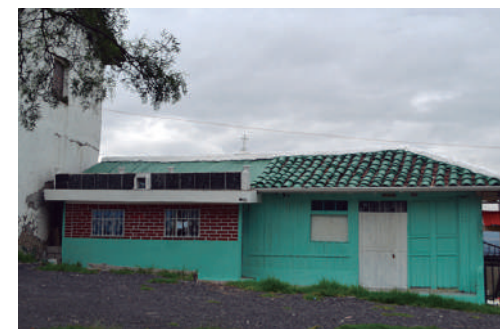
Año 2016 Estado Actual: Sustituida
