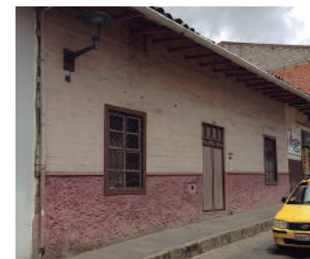
Año 2016 Estado Actual: No localizada
