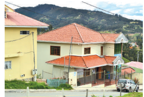
Año 2016 Estado Actual: Sustituida
