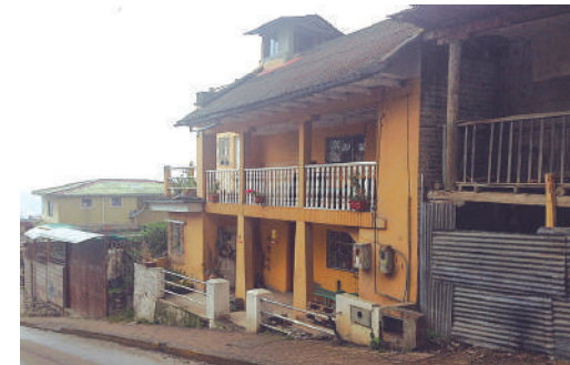
Año 2016 Estado Actual: Sustituída
