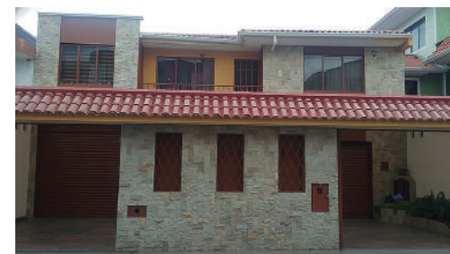
Año 2016 Estado Actual: Sustituida
