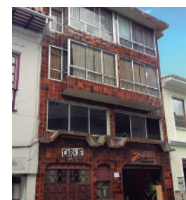
Año 2016 Estado Actual: Sustituida
