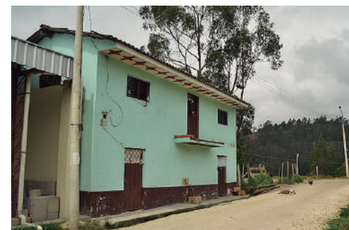
Año 2016 Estado Actual: Sustituida
