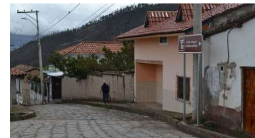
Año 2016 Estado Actual: Sustituida
