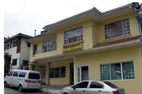
Año 2016 Estado Actual: Sustituida
