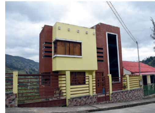
Año 2016 Estado Actual: Sustituida
