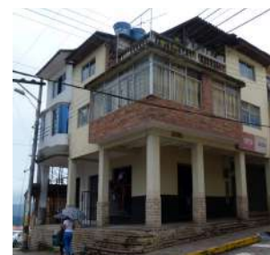
Año 2016 Estado Actual: Sustituida
