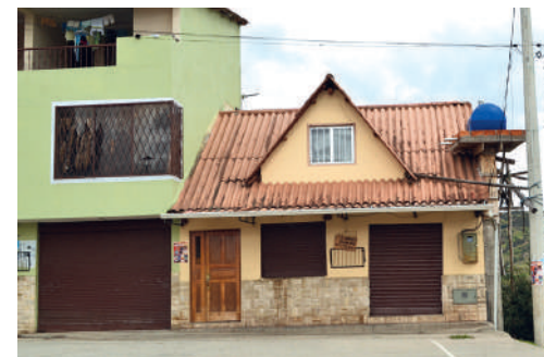
Año 2016 Estado Actual: Sustituida
