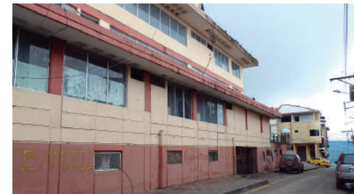
Año 2016 Estado Actual: Sustituida
