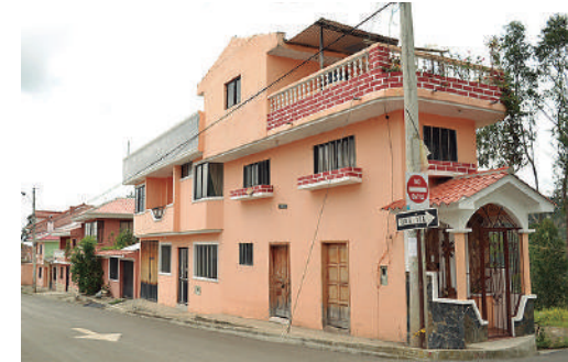
Año 2016 Estado Actual: Sustituida
