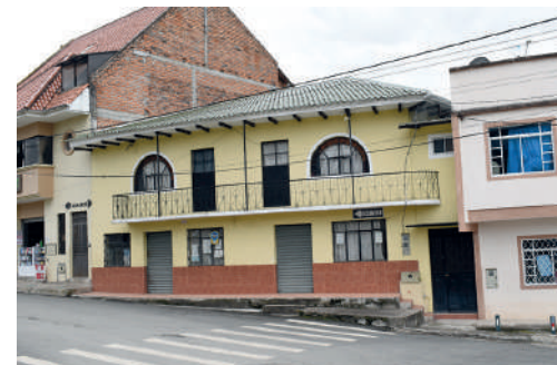
Año 2016 Estado Actual: Sustituida
