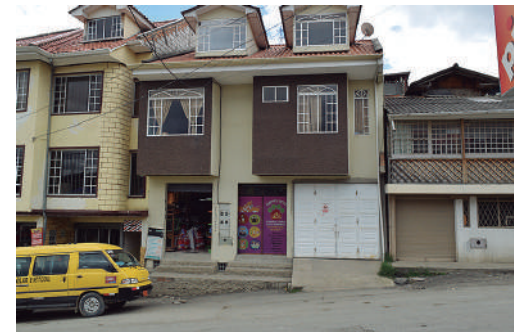
Año 2016 Estado Actual: Sustituida
