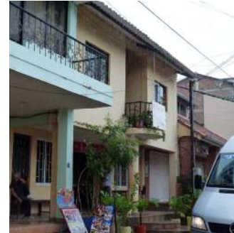
Año 2016 Estado Actual: Sustituida
