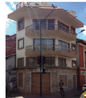
Año 2016 Estado Actual: Sustituida
