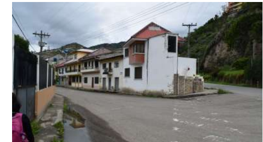
Año 2016 Estado Actual: Sustituida
