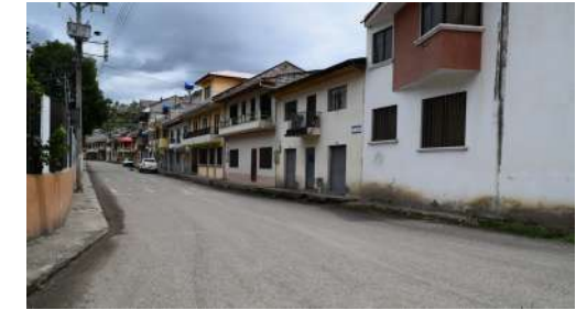
Año 2016 Estado Actual: Sustituida
