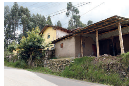
Año 2016 Estado Actual: Sustituida
