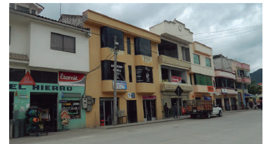
Año 2016 Estado Actual: Sustituida
