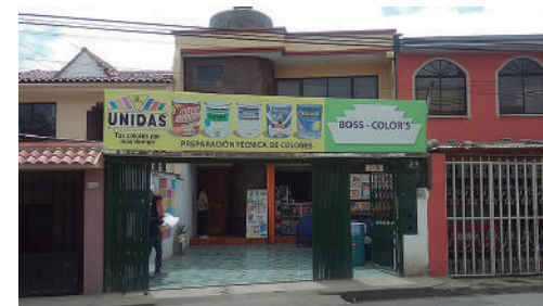
Año 2016 Estado Actual: Sustituida
