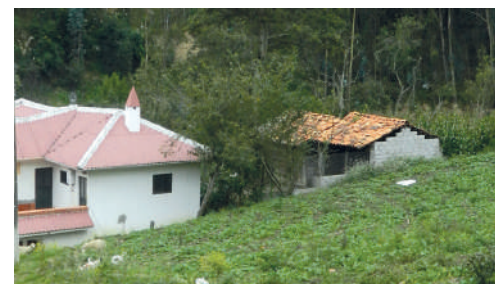
Año 2016 Estado Actual: Sustituida
