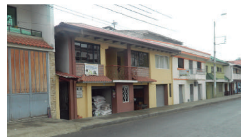
Año 2016 Estado Actual: Sustituida
