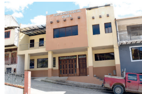
Año 2016 Estado Actual: Sustituida
