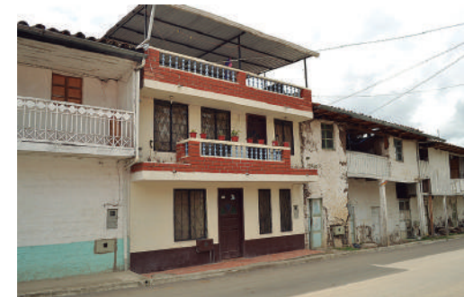
Año 2016 Estado Actual: Sustituida
