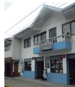
Año 2016 Estado Actual: Sustituida
