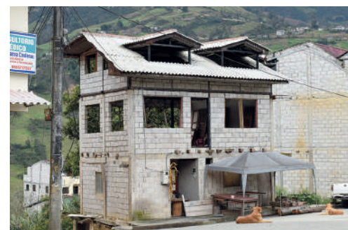
Año 2016 Estado Actual: Sustituida
