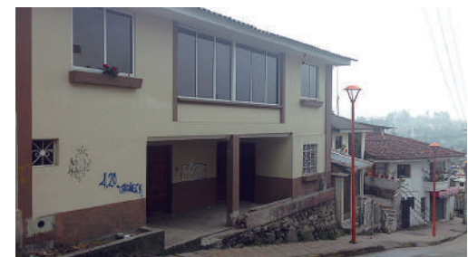
Año 2016 Estado Actual: Sustituida
