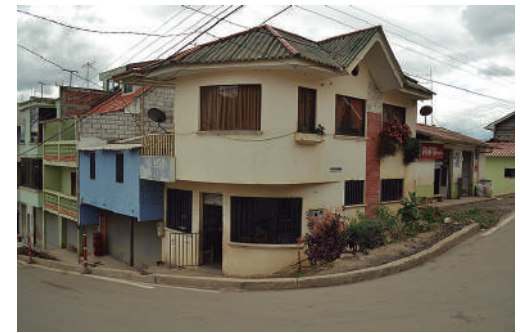
Año 2016 Estado Actual: Sustituida
