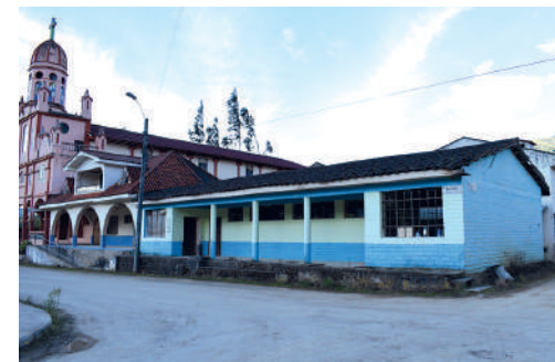
Año 2016 Estado Actual: Sustituida
