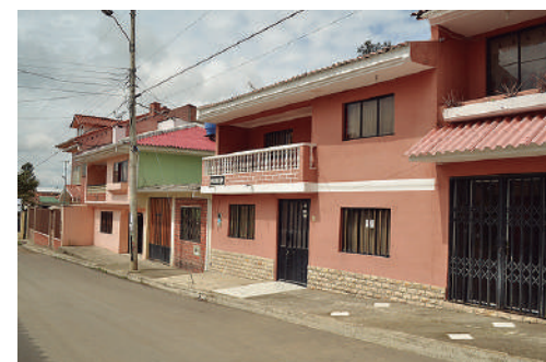
Año 2016 Estado Actual: Sustituida
