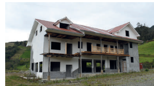
Año 2016 Estado Actual: Sustituida
