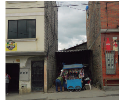
Año 2016 Estado Actual: Sustituida
