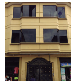
Año 2016 Estado Actual: Sustituida
