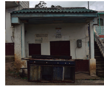
Año 2016 Estado Actual: Sustituida
