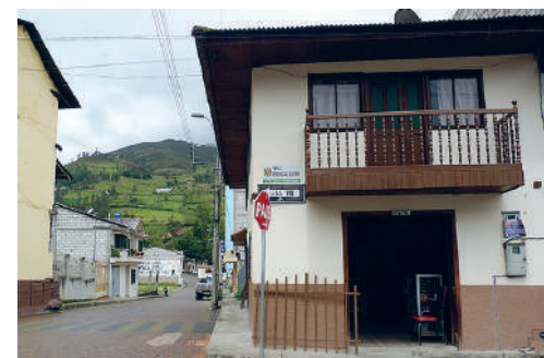
Año 2016 Estado Actual: Sustituido
