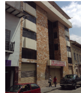
Año 2016 Estado Actual: Sustituida
