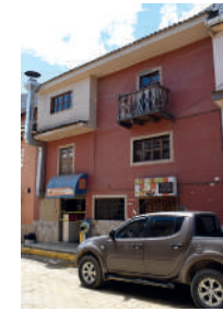
Año 2016 Estado Actual: Sustituido
