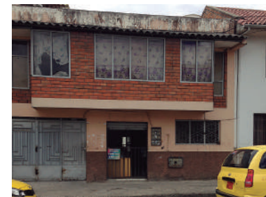
Año 2016 Estado Actual: Sustituida
