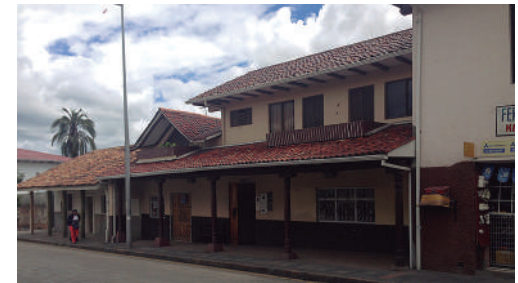
Año 2016 Estado Actual: Sustituido
