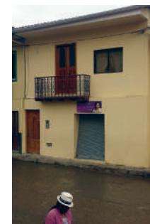
Año 2016 Estado Actual: Sustituida
