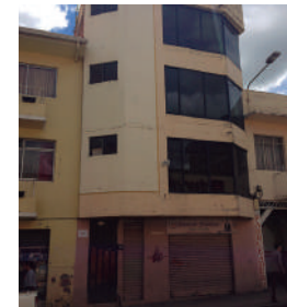
Año 2016 Estado Actual: Sustituido
