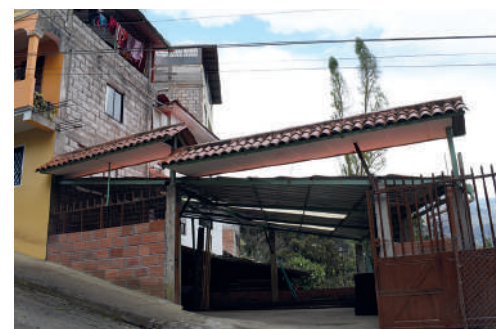
Año 2016 Estado Actual: Sustituida
