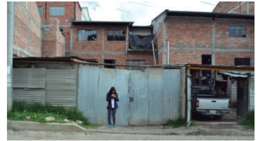
Año 2016 Estado Actual: Sustituida
