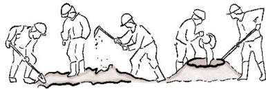
1. Extracción del material y mezcla
