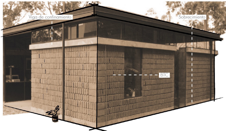
Fig. 2.5.4 | El uso de los bloques de tierra en el proyecto Lienzo de Barro. | Fuente: Autoría Propia (2024).
