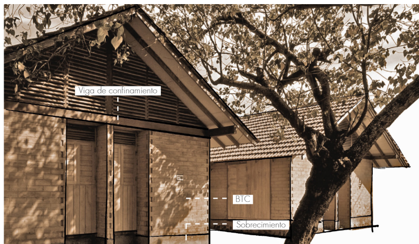
Fig. 2.5.1 | El uso del BTC en el proyecto Kirinda Houses. | Fuente: Autoría Propia (2024).
