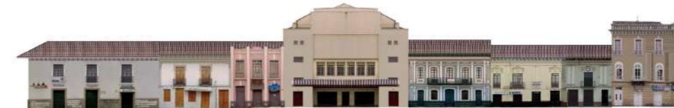
TRAMO ESTE PLAZA
