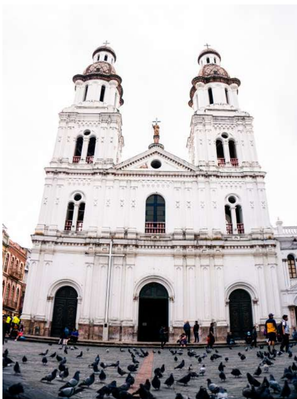
Figura 1: Espadaña del Templo de Santo Domingo Fuente: Andersson Sanmartín, Departamento de Comunicación de la Universidad del Azuay
