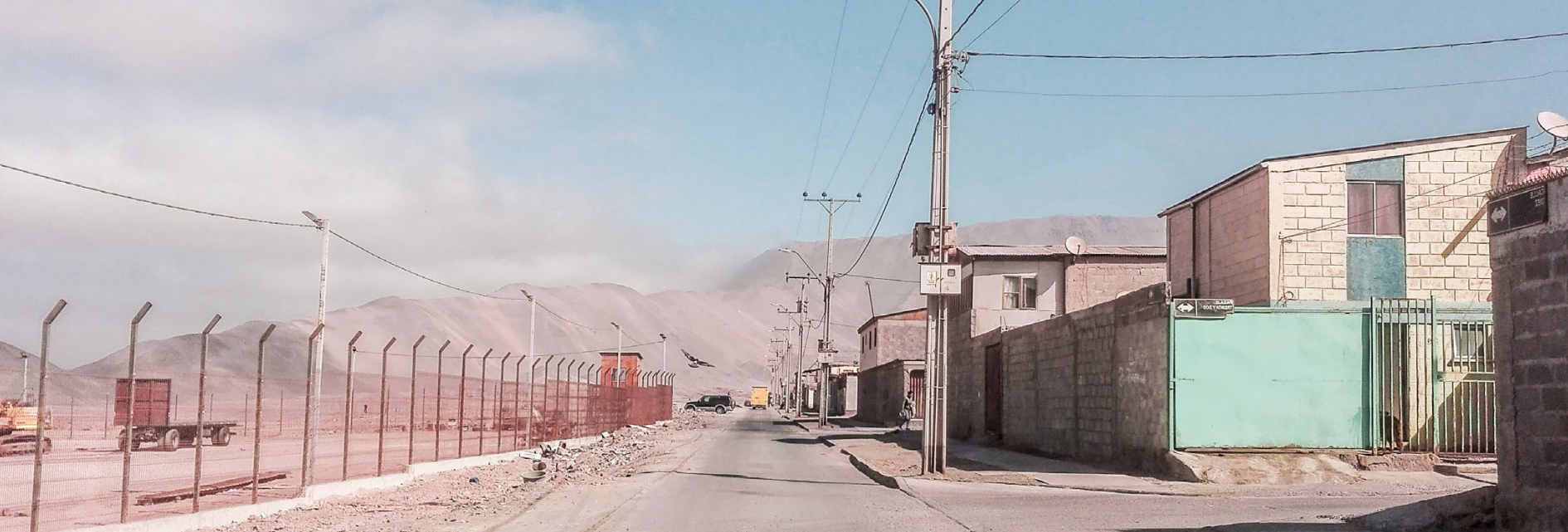
Figura 17. Borde con parqueadero de vehículos pesados.
