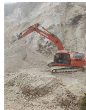
Figura 139. Equipo Pesado en Frente de Explotación
