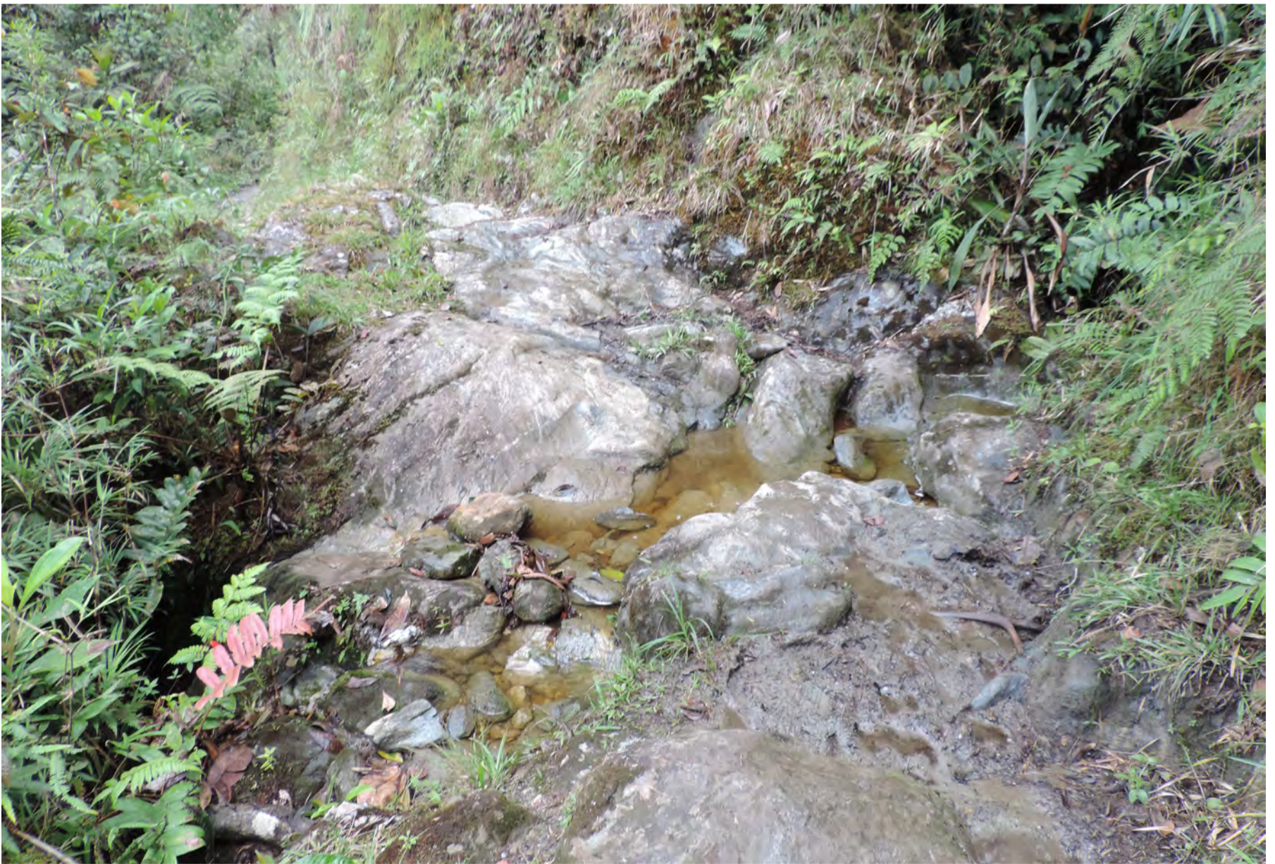
Figura 172 Canal sobre afloramiento rocoso para la evacuación de agua de la quebrada.
