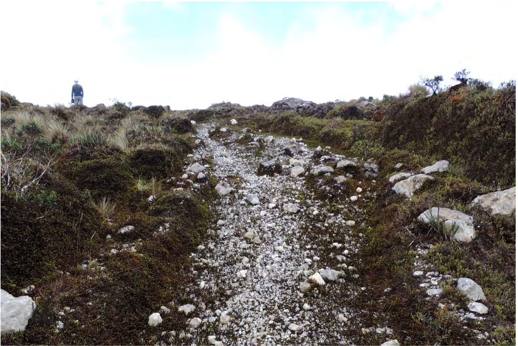
Figura 84 Camino sobre roca natural y canales laterales de desfogue de agua.
