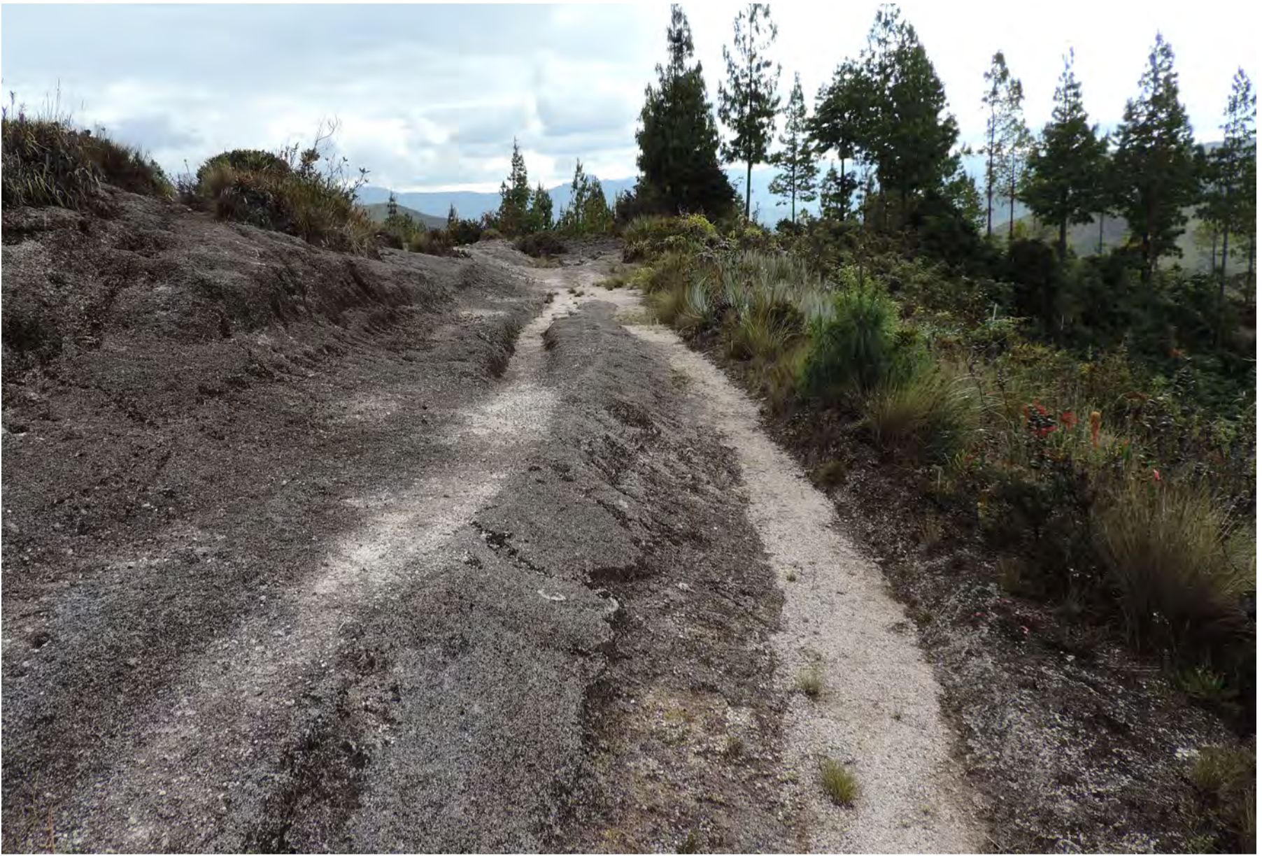
Figura 22 Camino sobre afloramiento rocoso
