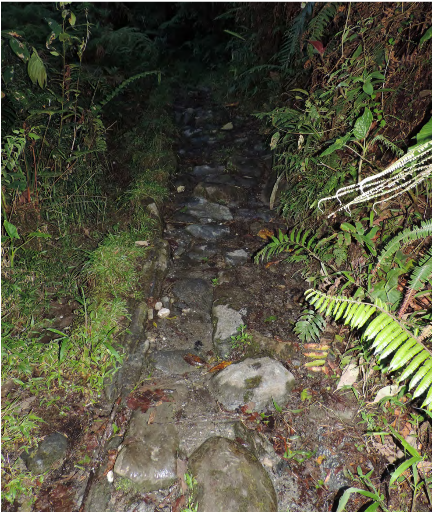
Figura 176 Calzada empedrada en buen estado de conservación .
