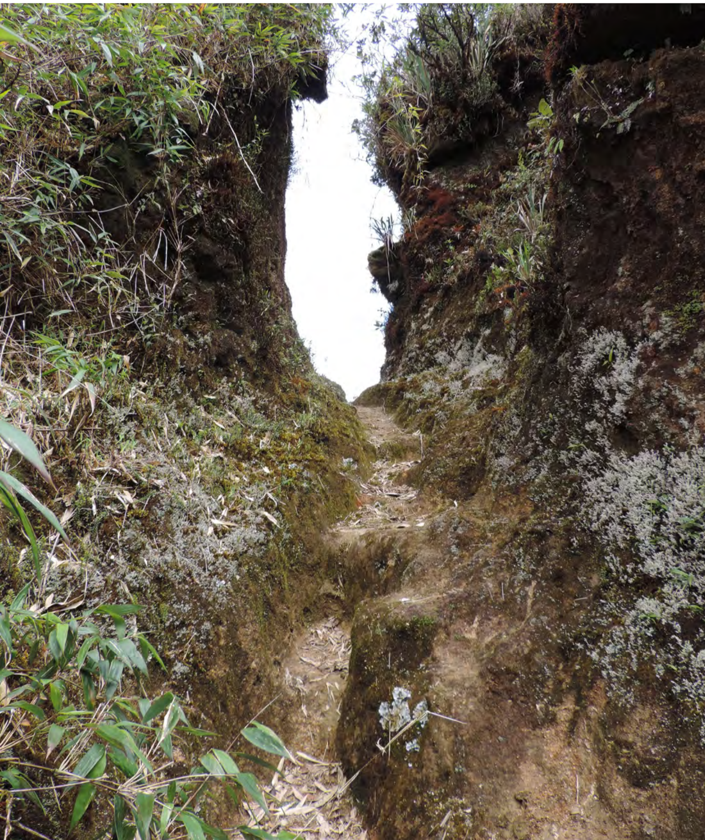
Figura 152 Vía excavada en afloramiento rocoso y perfil de taludes laterales.
