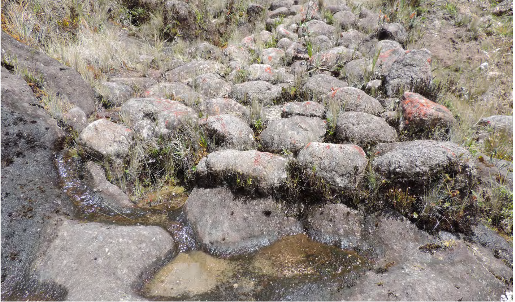
Figura 53 Perspectiva de la técnica de construcción del empedrado cimentado sobre cunetas excavadas en el afloramiento rocoso.
