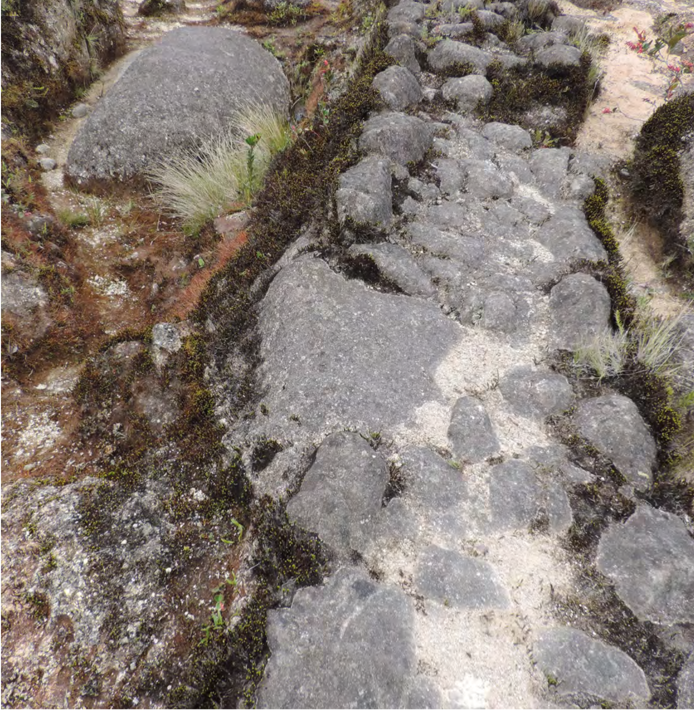
Figura 49 Empedrado construido y adaptado al afloramiento rocoso.
