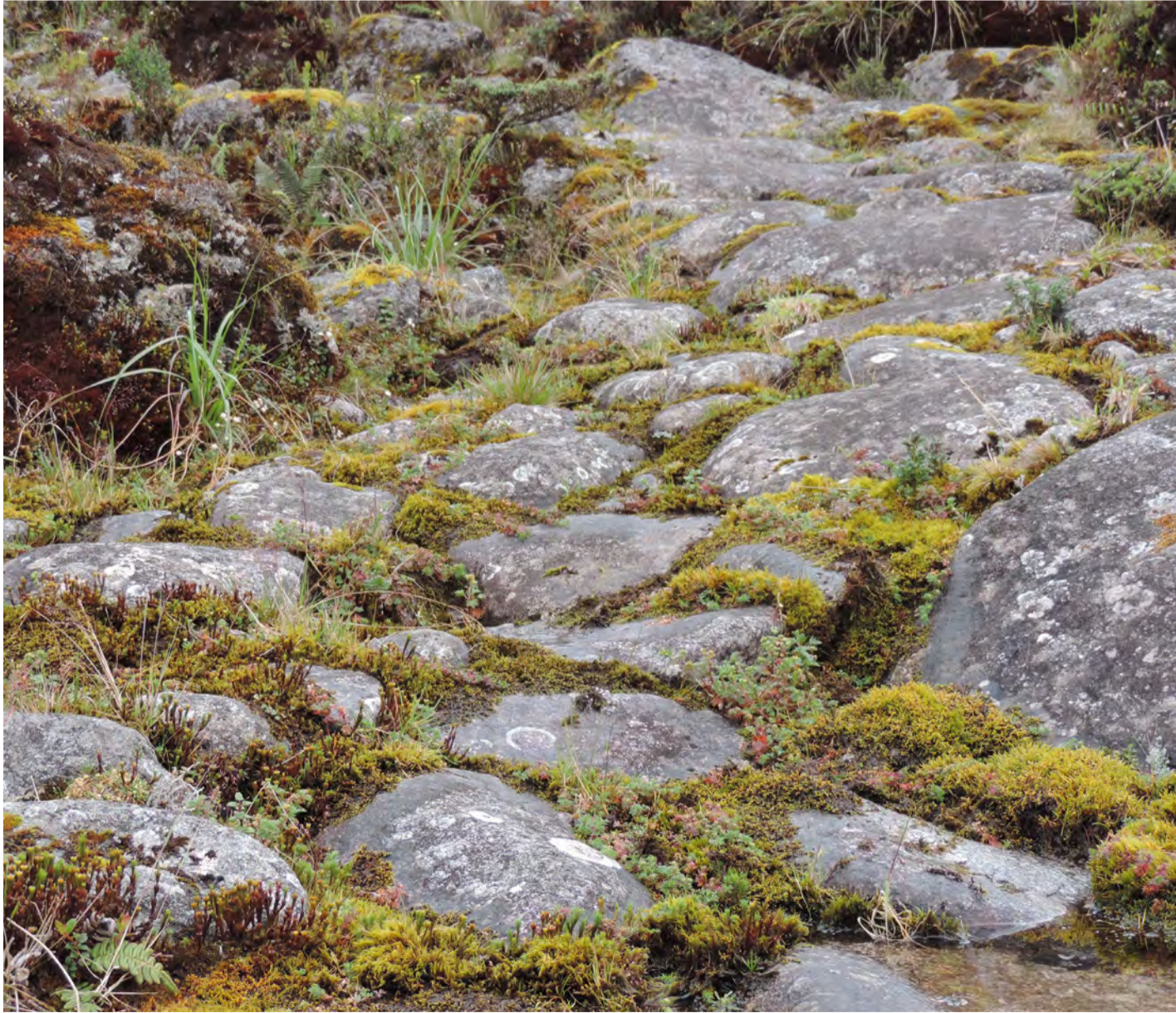
Figura 116 Grandes piedras planchas transportadas y acopladas al afloramiento rocos conformando la calzada.
