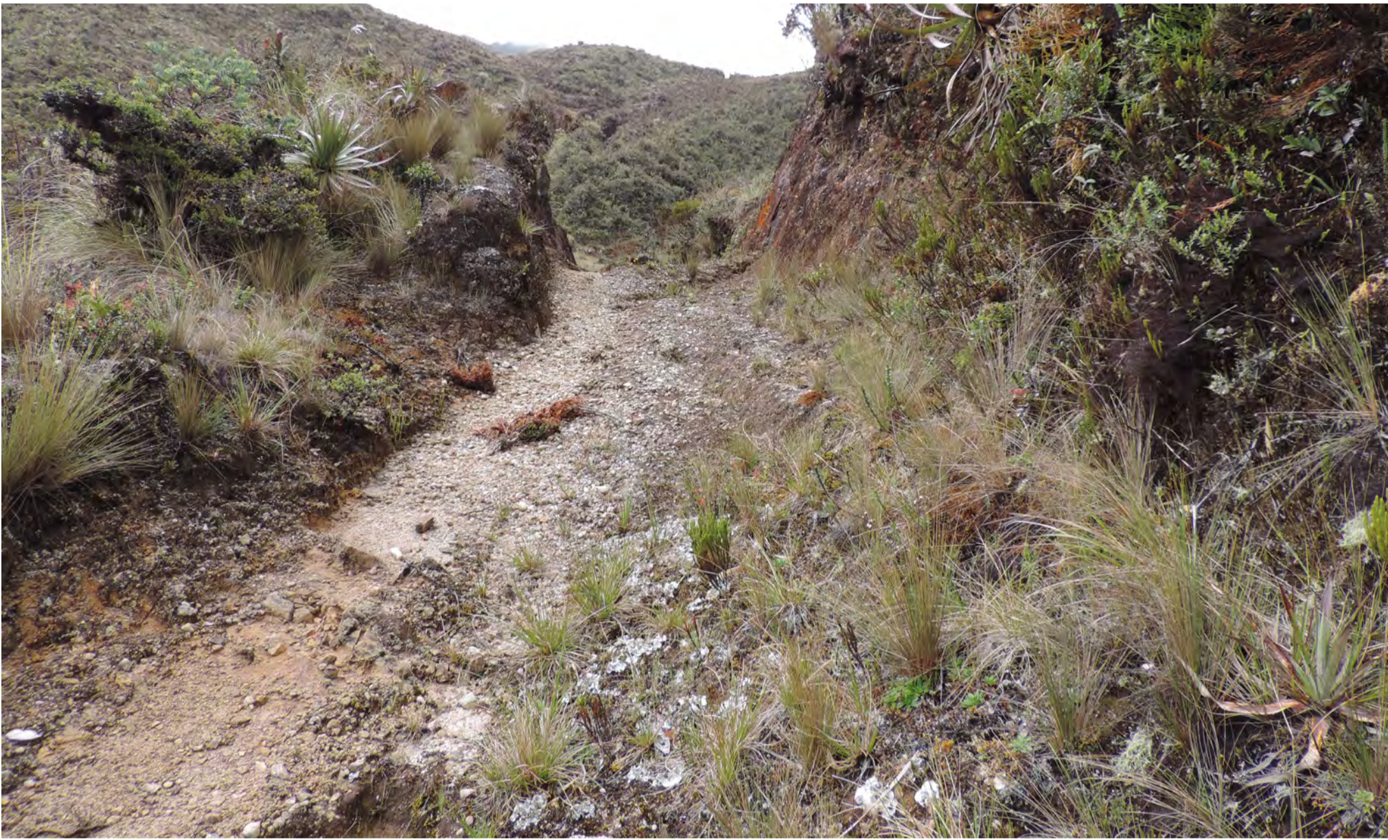
Figura 65 Camino cavado en roca natural y protegido por cortes de talud lateral .
