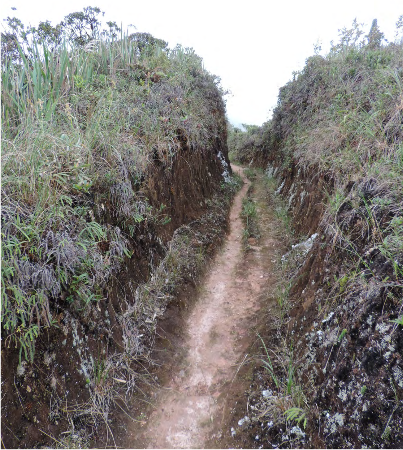
Figura 156 Camino excavado en roca natural deleznable y cortes de talud.
