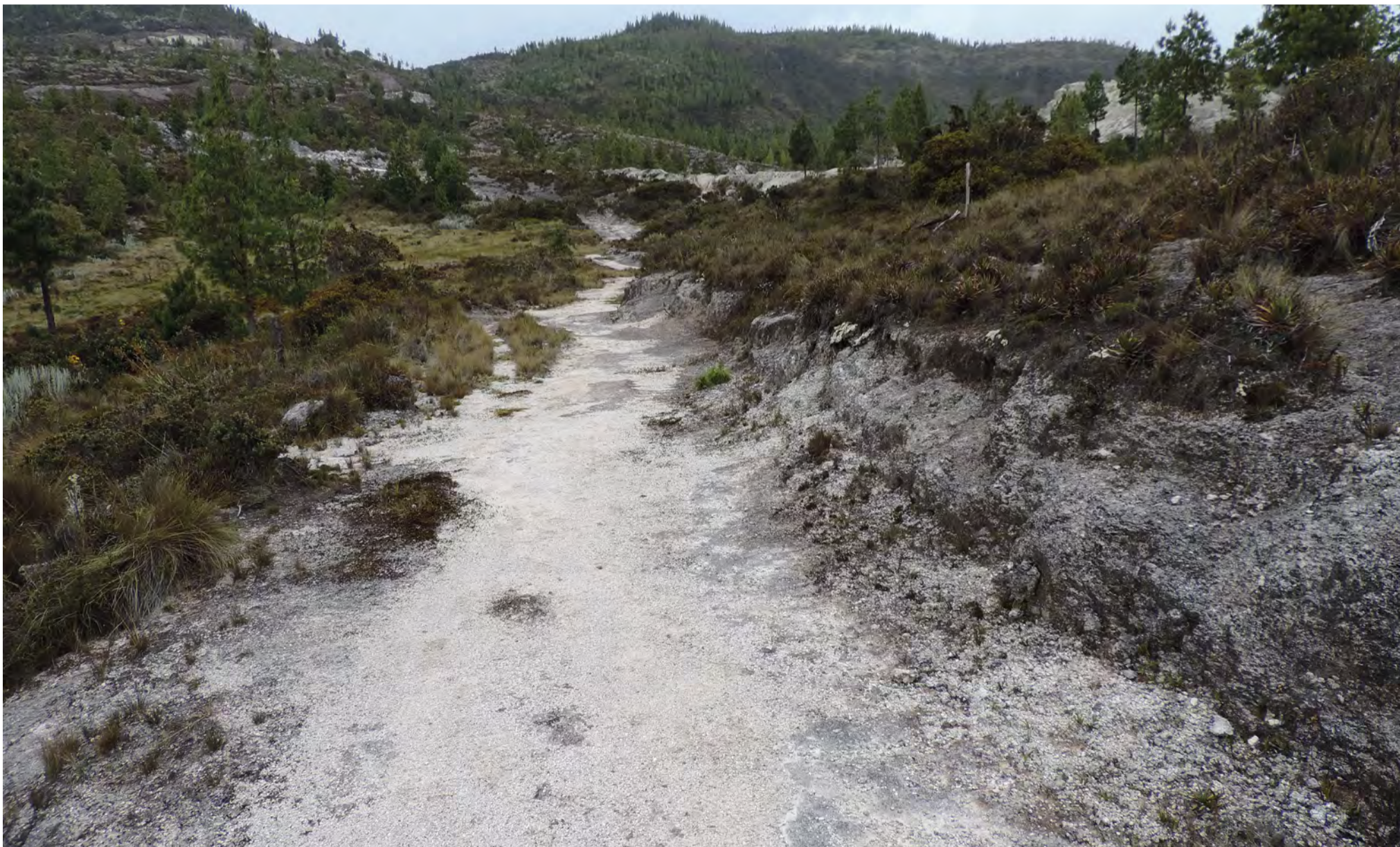
Figura 23 Horizonte del camino sobre afloramiento rocoso y cortes de talud lateral
