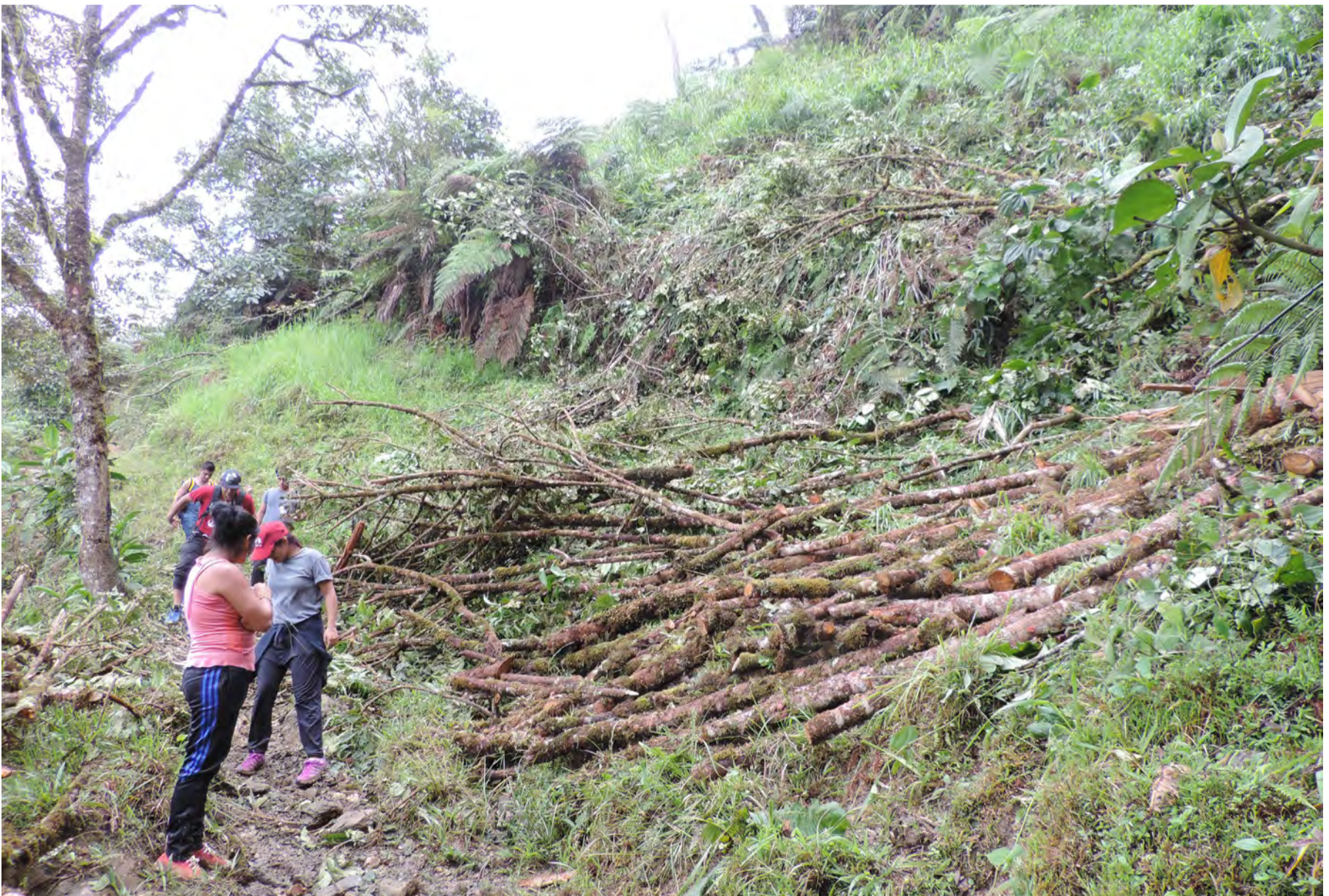
Figura 192 Limpieza de la vegetación para el mantenimiento del camino.
