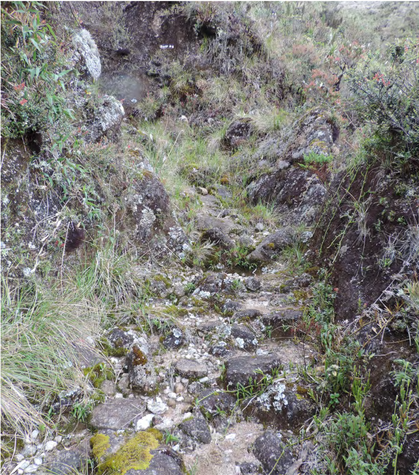
Figura 70 Camino empedrado y sistema de graderías protegidos por taludes laterales.
