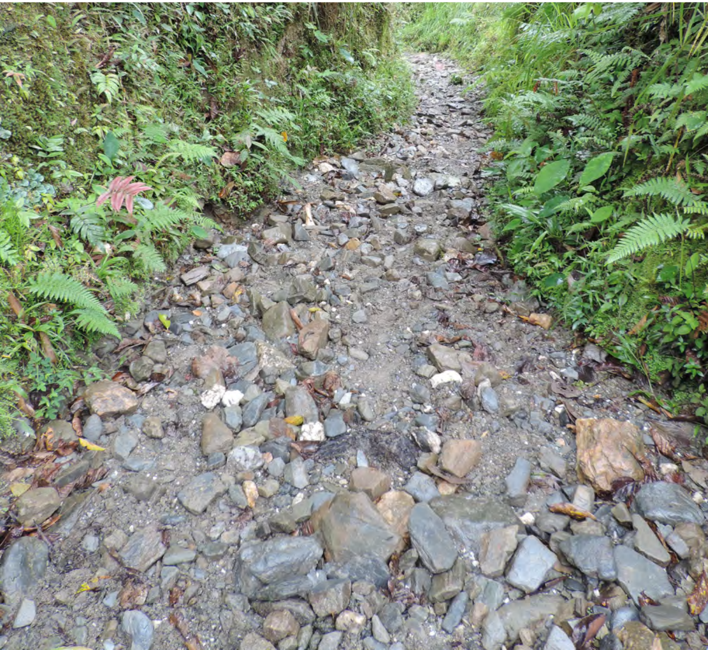
Figura 184 Camino en curva de dos metros de ancho y taludes laterales .
