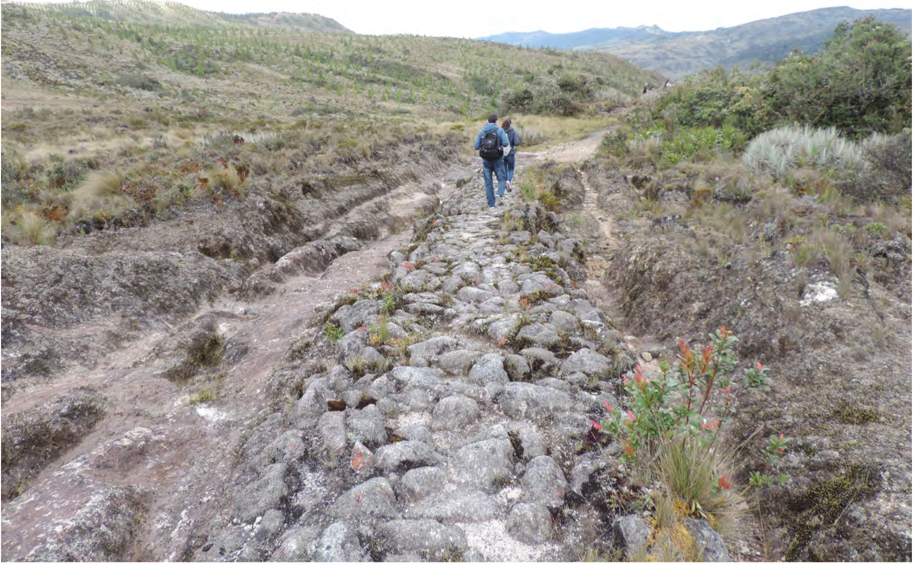
Figura 29 Camino empedrado de un metro de ancho y restos de canales laterales
