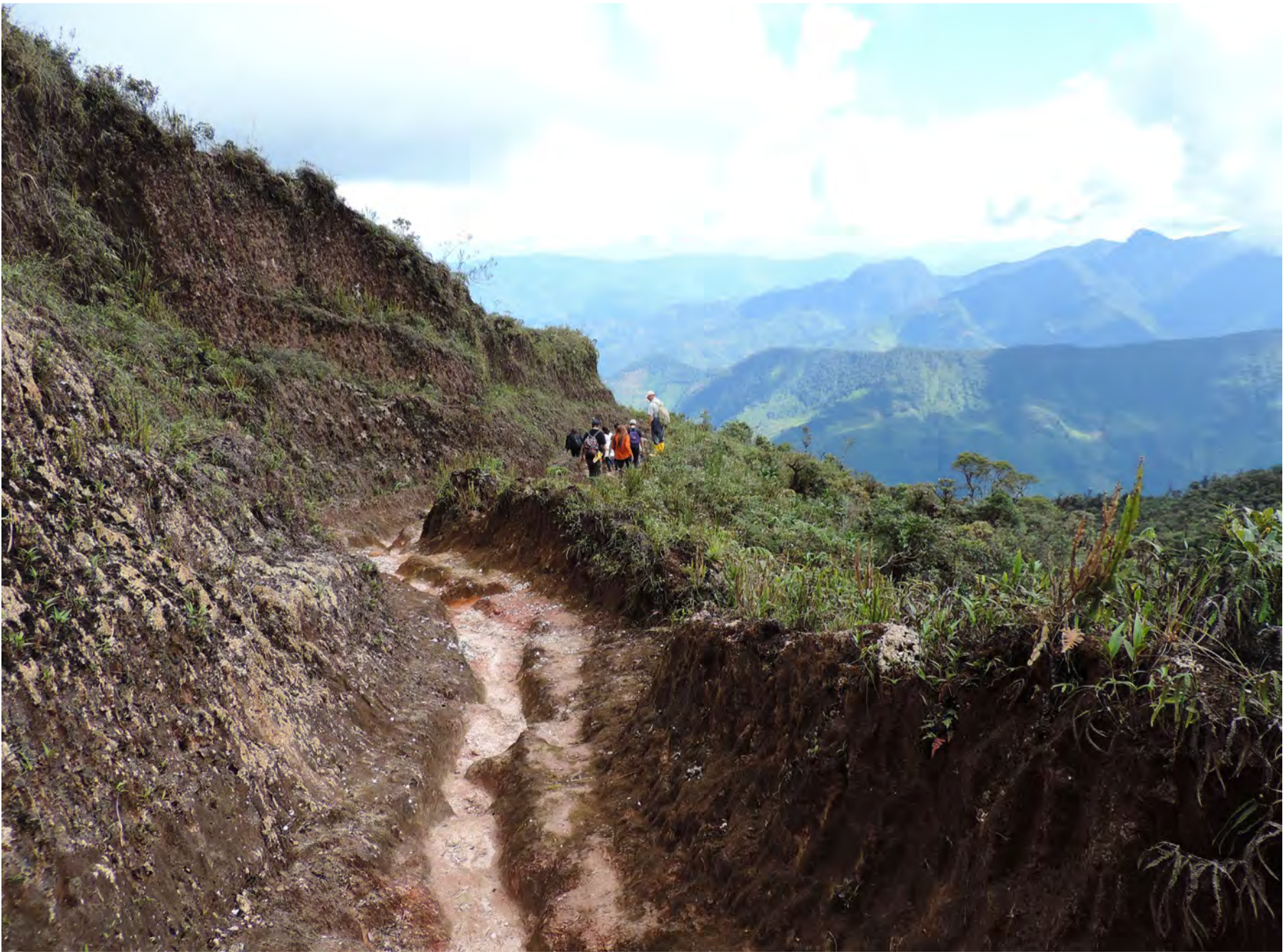
Figura 160 Panorámica de la vía de 2 metros de ancho excavada sobre roca natural.
