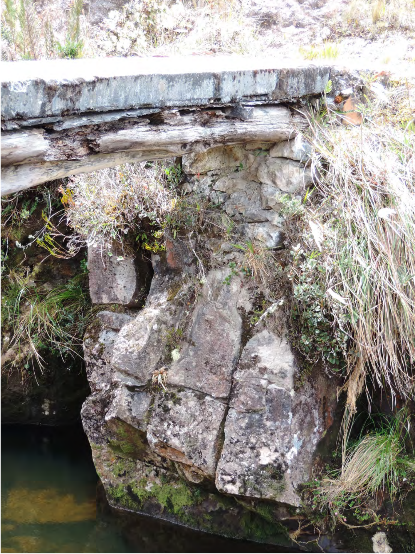
Figura 37 Plataforma antigua reutilizada para la construcción de un puente de hormigón armado.
