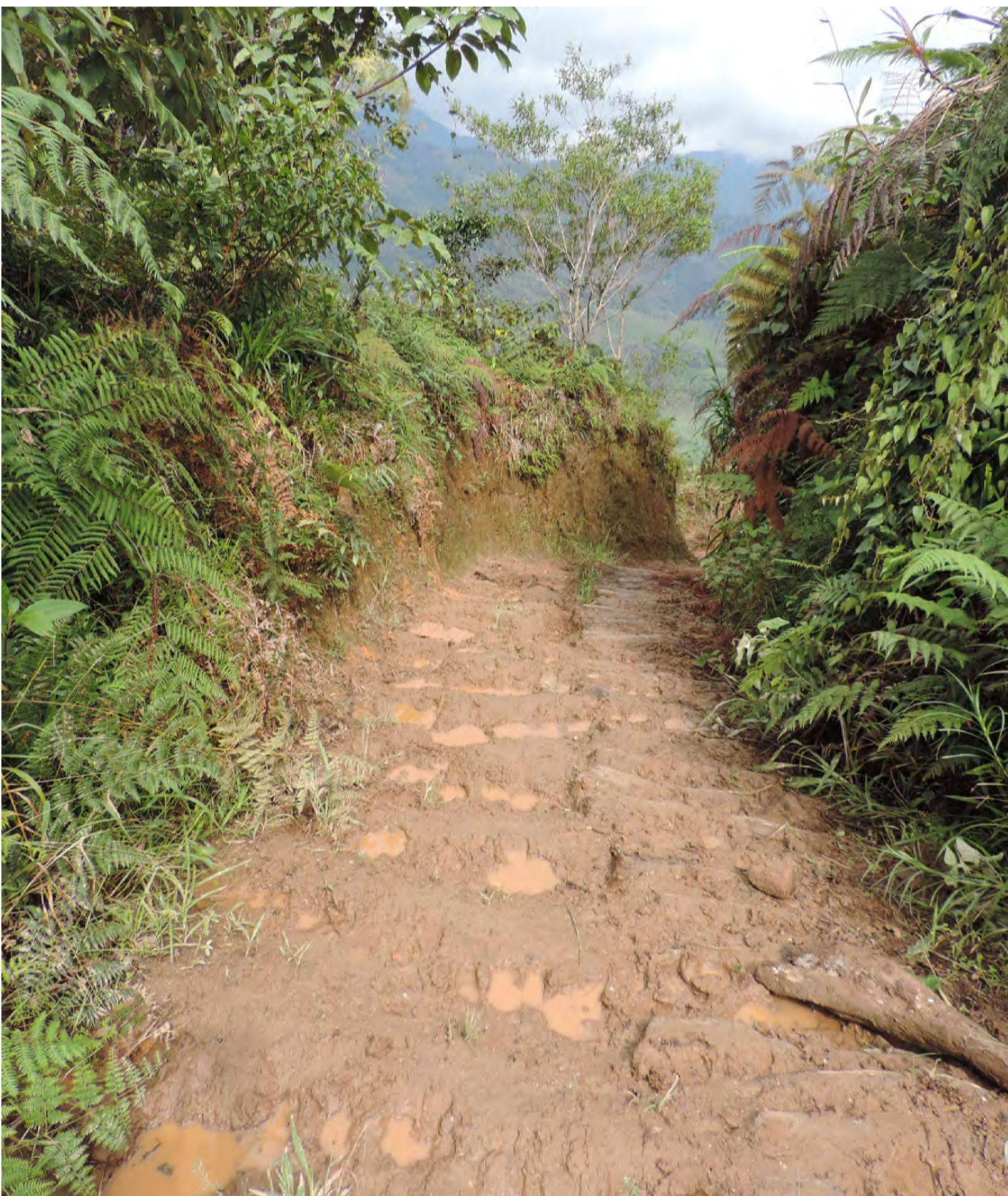
Figura 196 Camino de camellones y protegido con cortes de talud en ambos lados.
