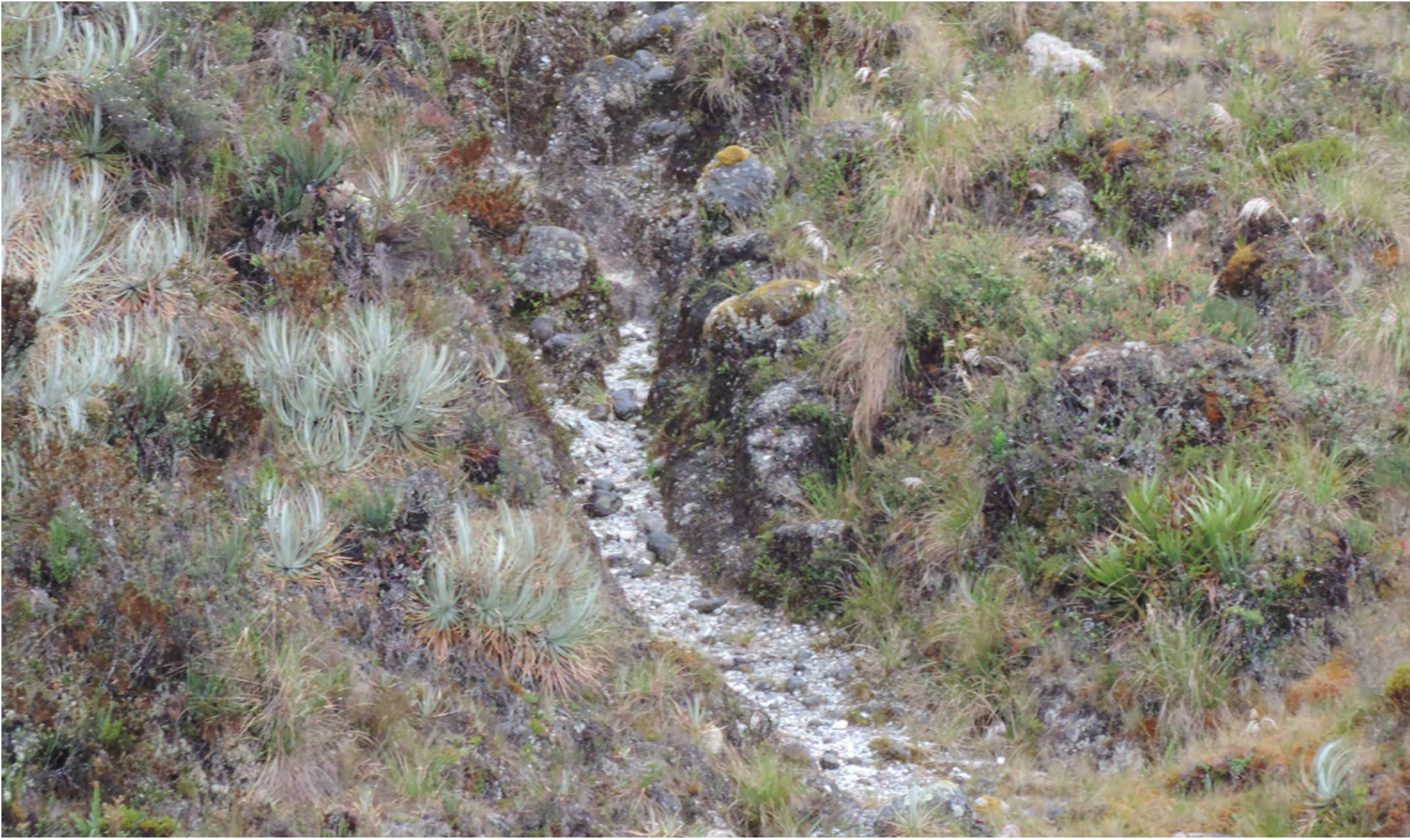
Figura 73 Empedrado y escalinata protegidos por cortes de talud de roca.
