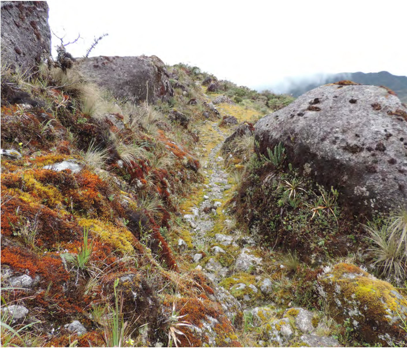
Figura 127 Calzada de un metro de ancho protegida por hileras de piedra y talud.
