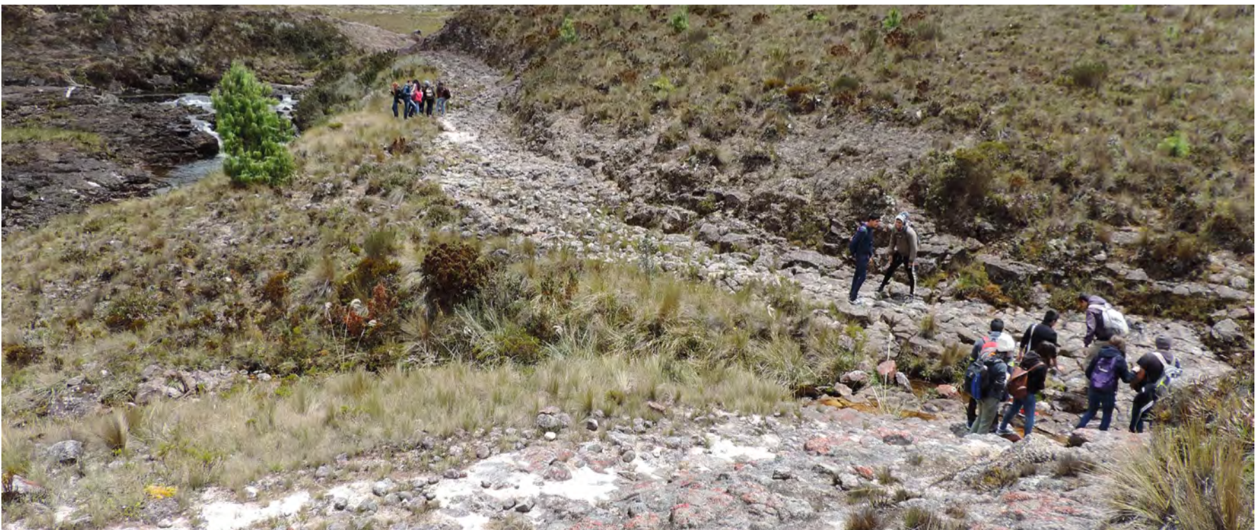
Figura 34 Camino sobre roca natural y cortes de talud lateral.
