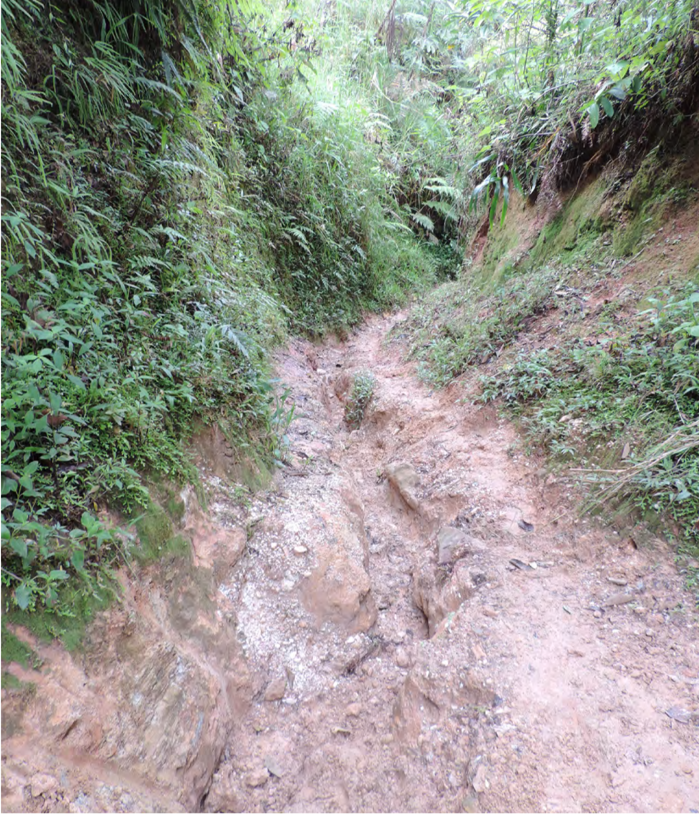
Figura 199 Segmento con cárcavas y taludes de más de tres metros de alto .
