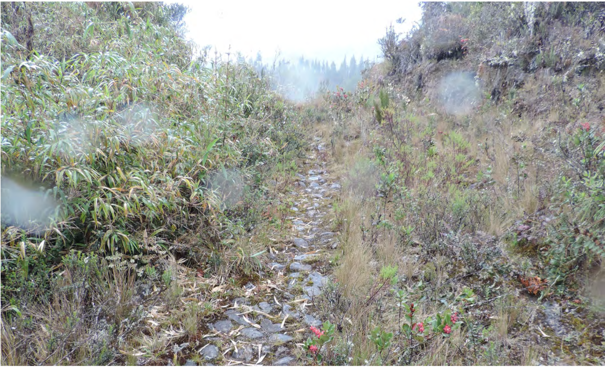
Figura 18 Camino empedrado y cortes de talud lateral
