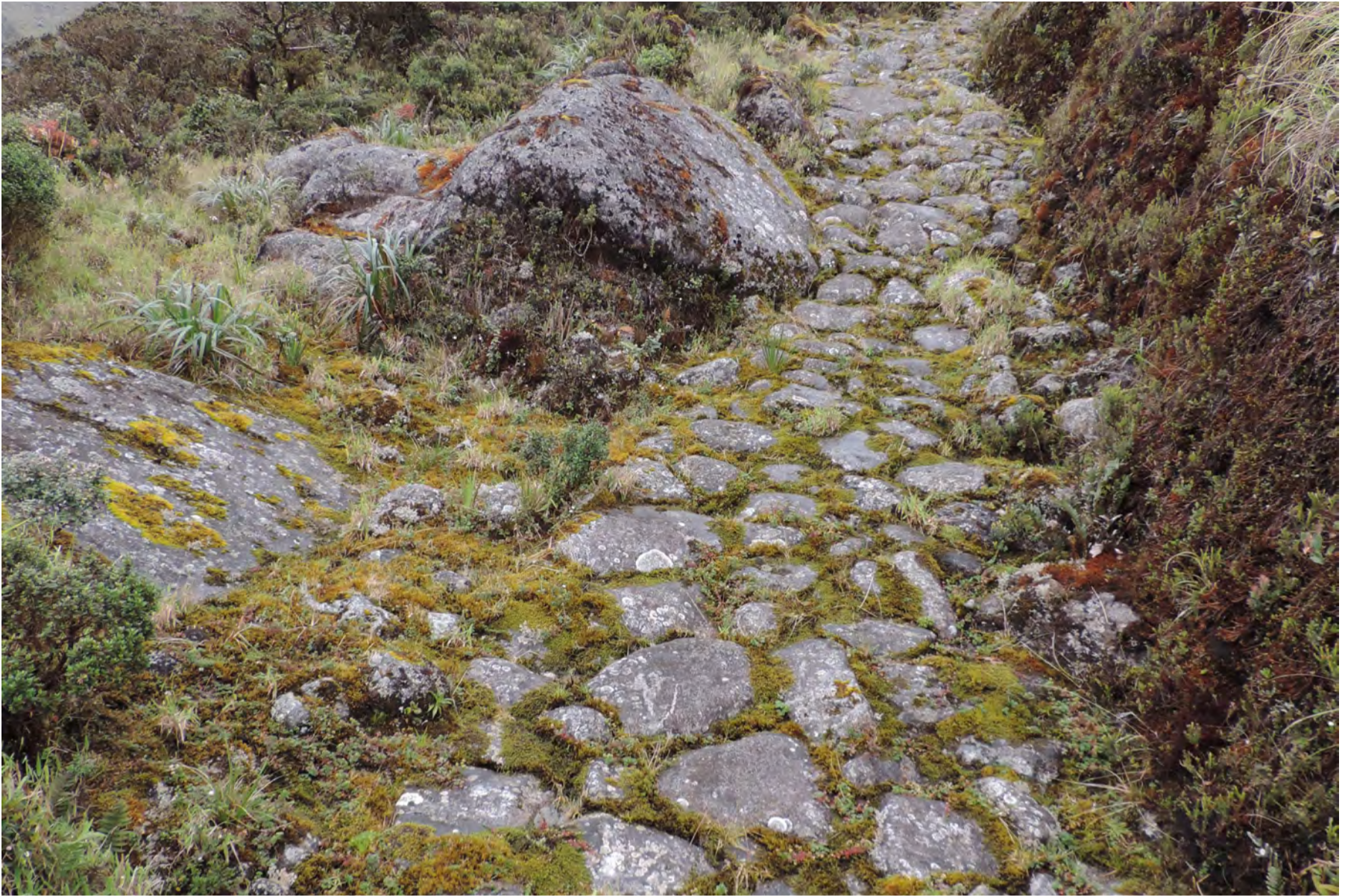
Figura 111 Piedras planchas transportadas y acomodadas conforman el empedrado del camino y talud lateral.
