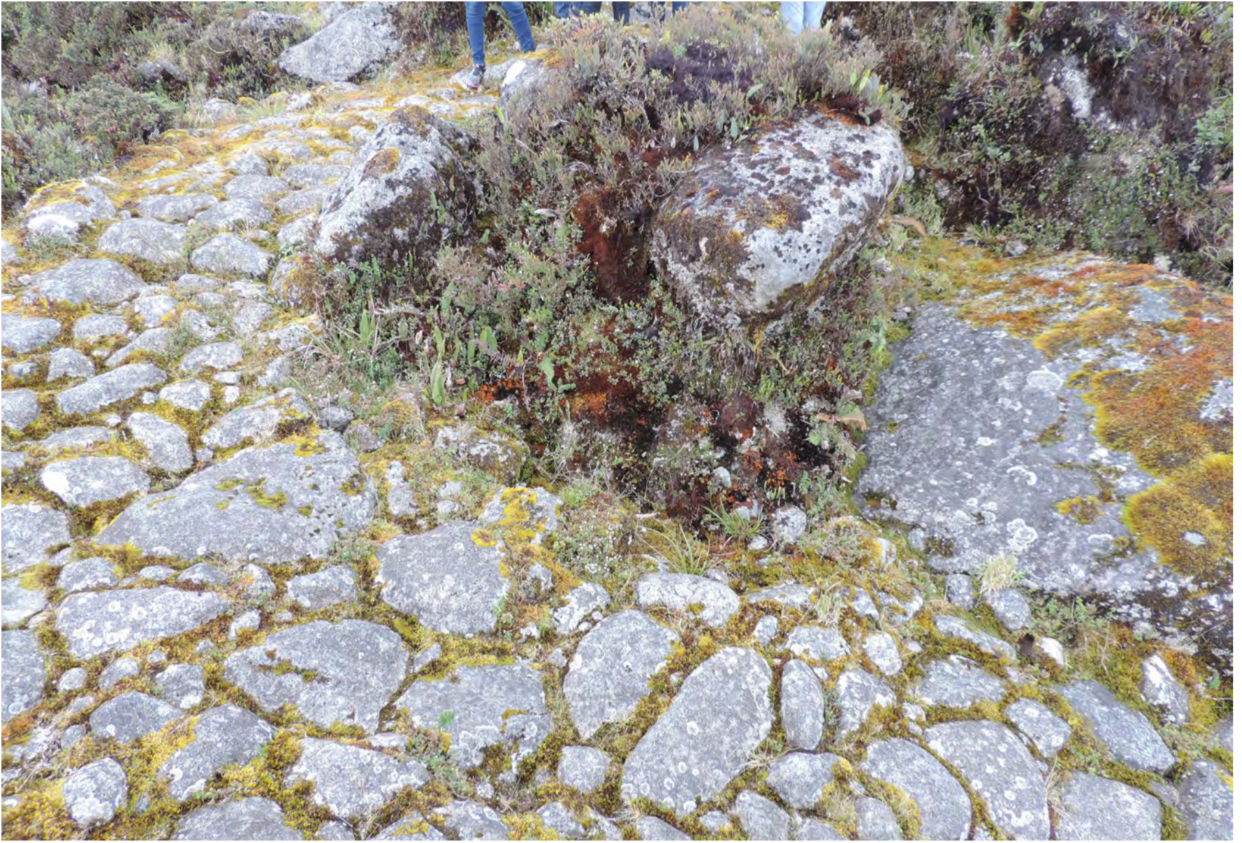
Figura 131 Vía en curva.
