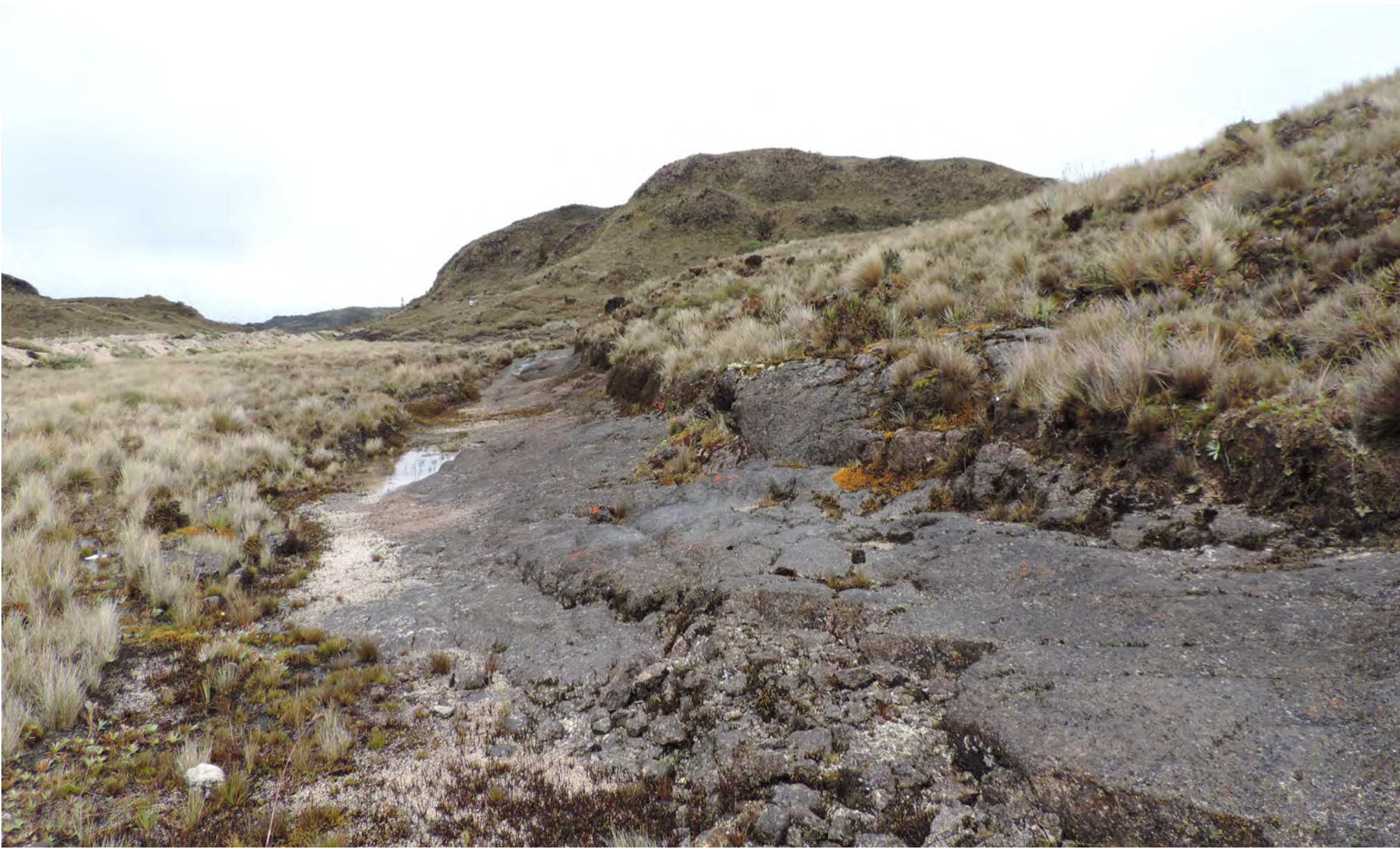
Figura 57 Camino de tres metros de ancho y cortes laterales de roca natural .
