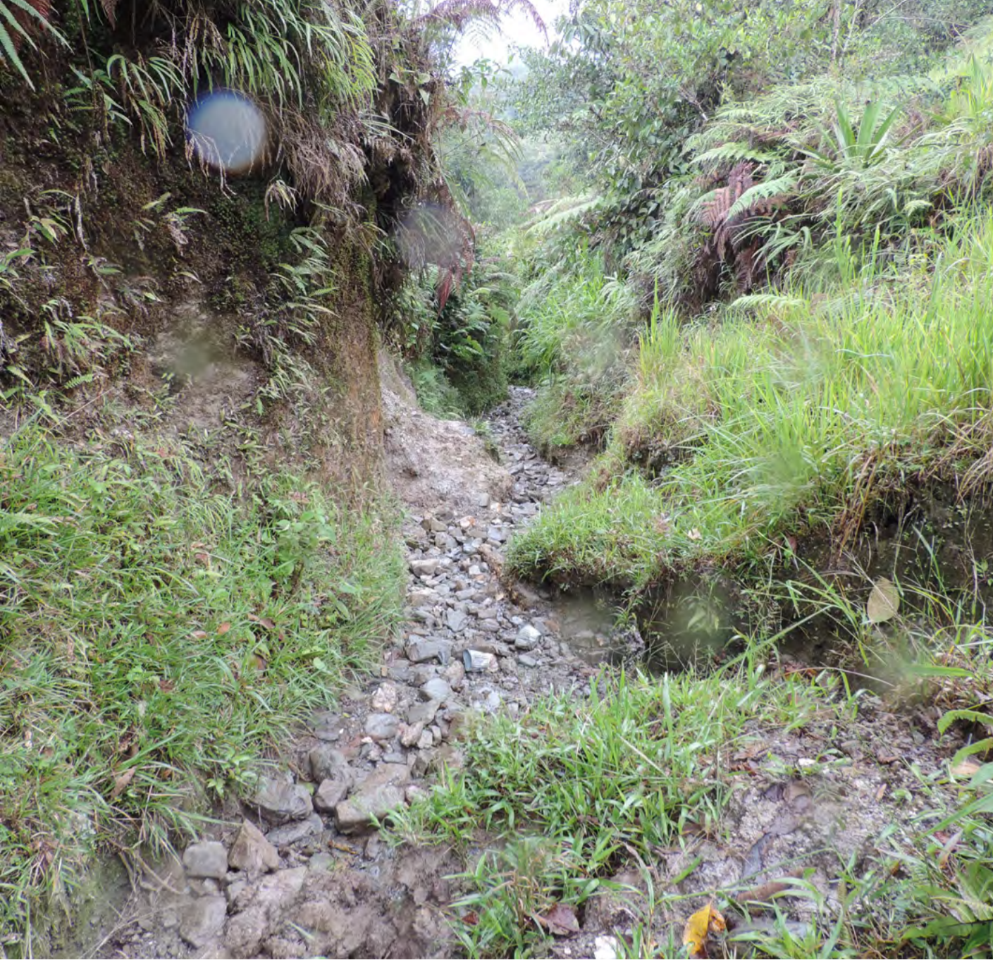
Figura 183 Cortes de talud de tierra protegen el camino.
