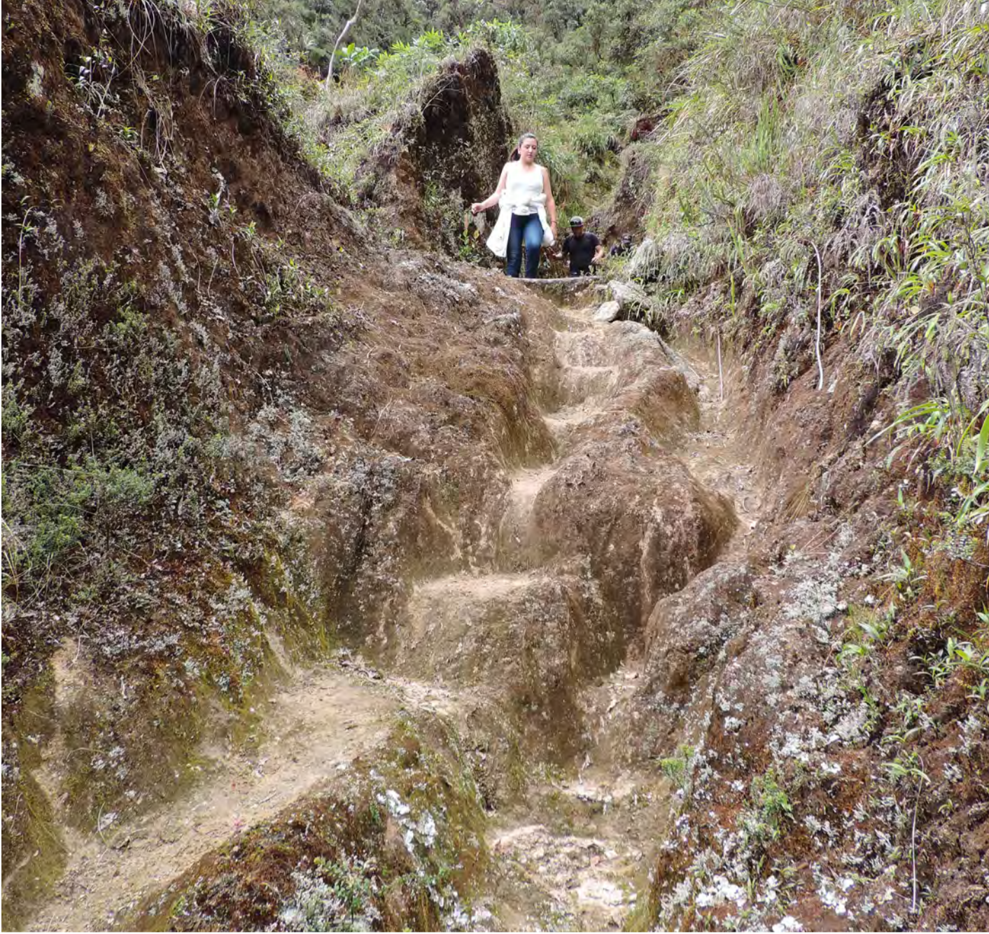
Figura 159 Camino excavado sobre afloramiento rocoso.
