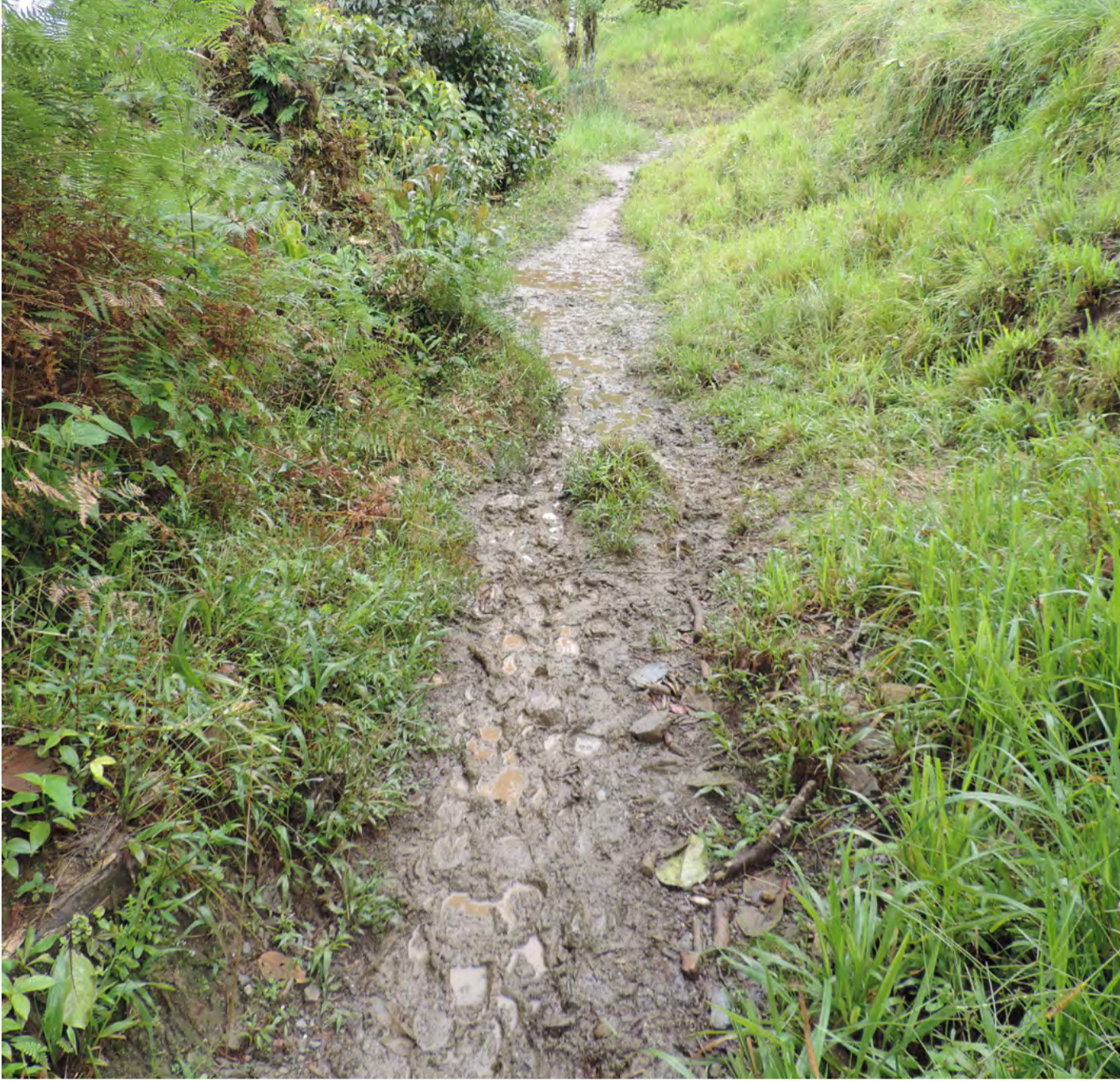
Figura 187 Camino sin rastro de empedrado y talud lateral.
