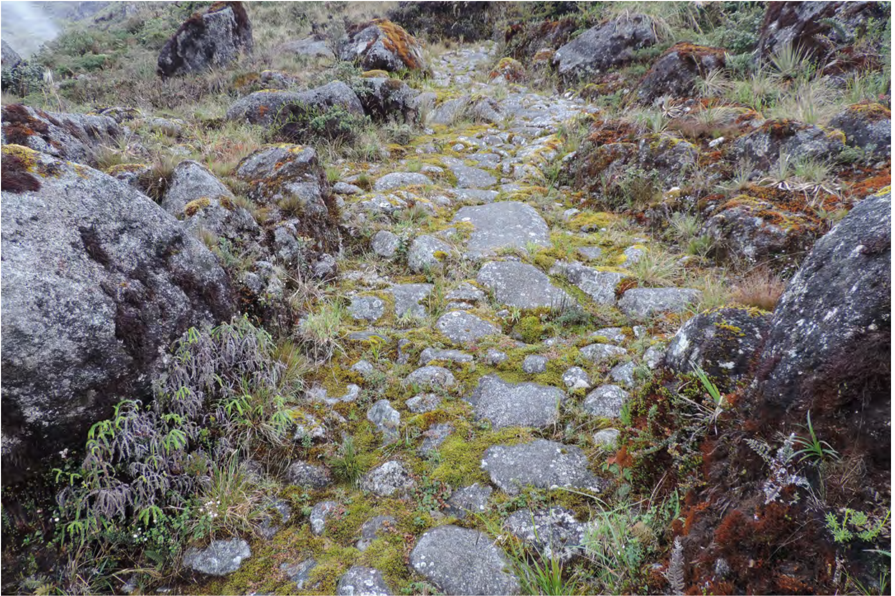
Figura 119 Grandes piedras plancha transportadas y usadas en la calzada de la vía.
