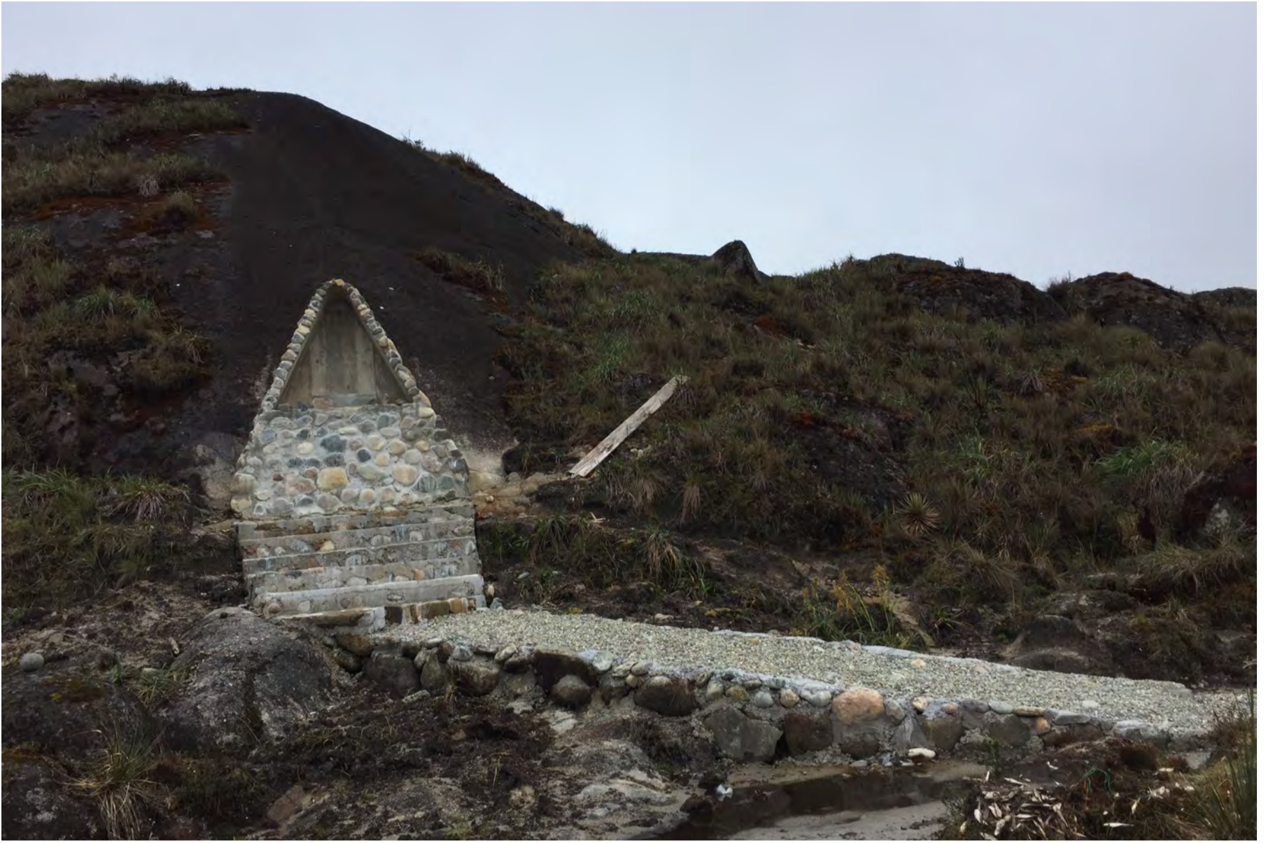
Figura 93 Construcción de un santuario en el área de Reserva Ecológica Yacuambi.
