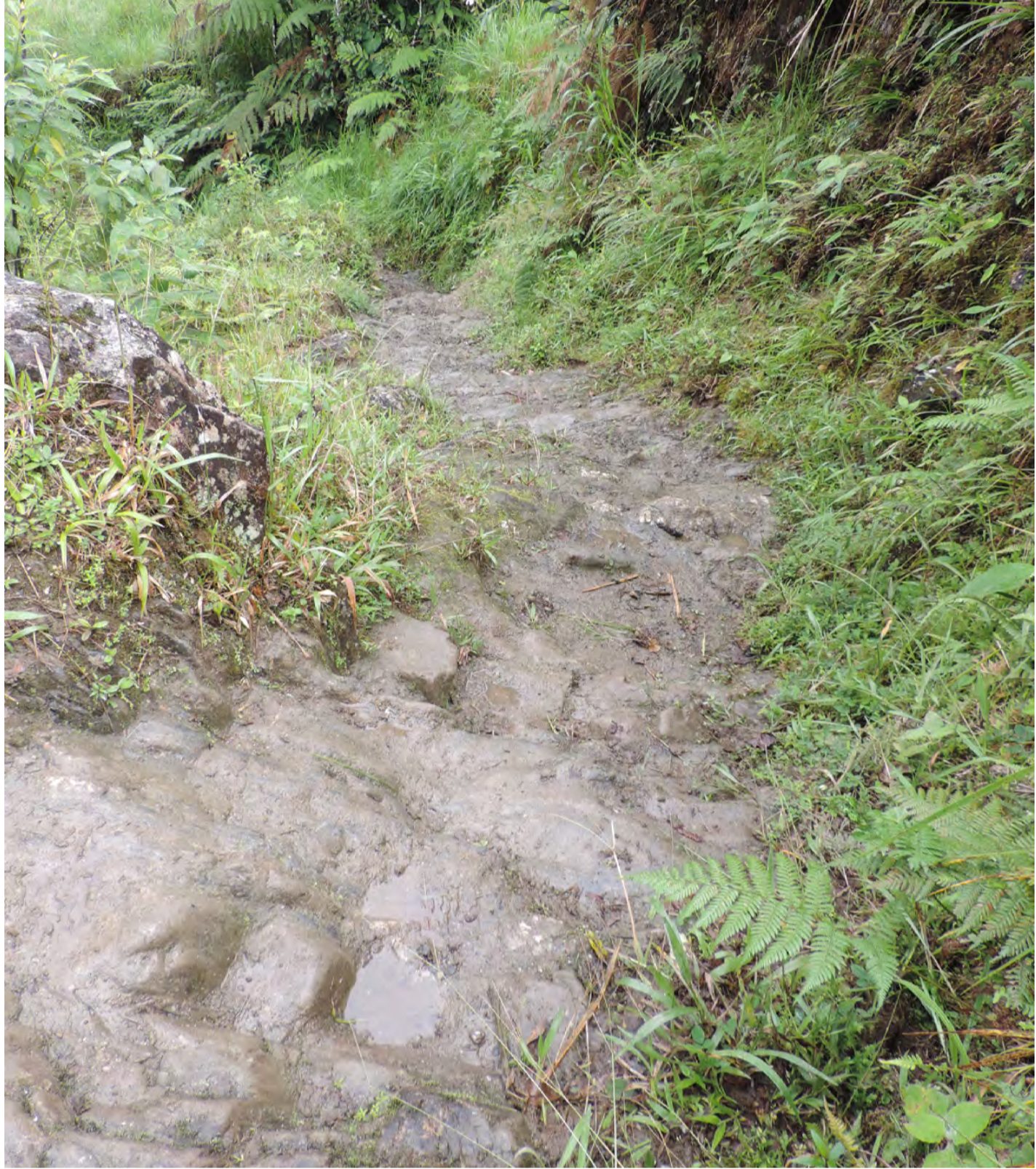
Figura 189 Camino trabajado en roca natural.
