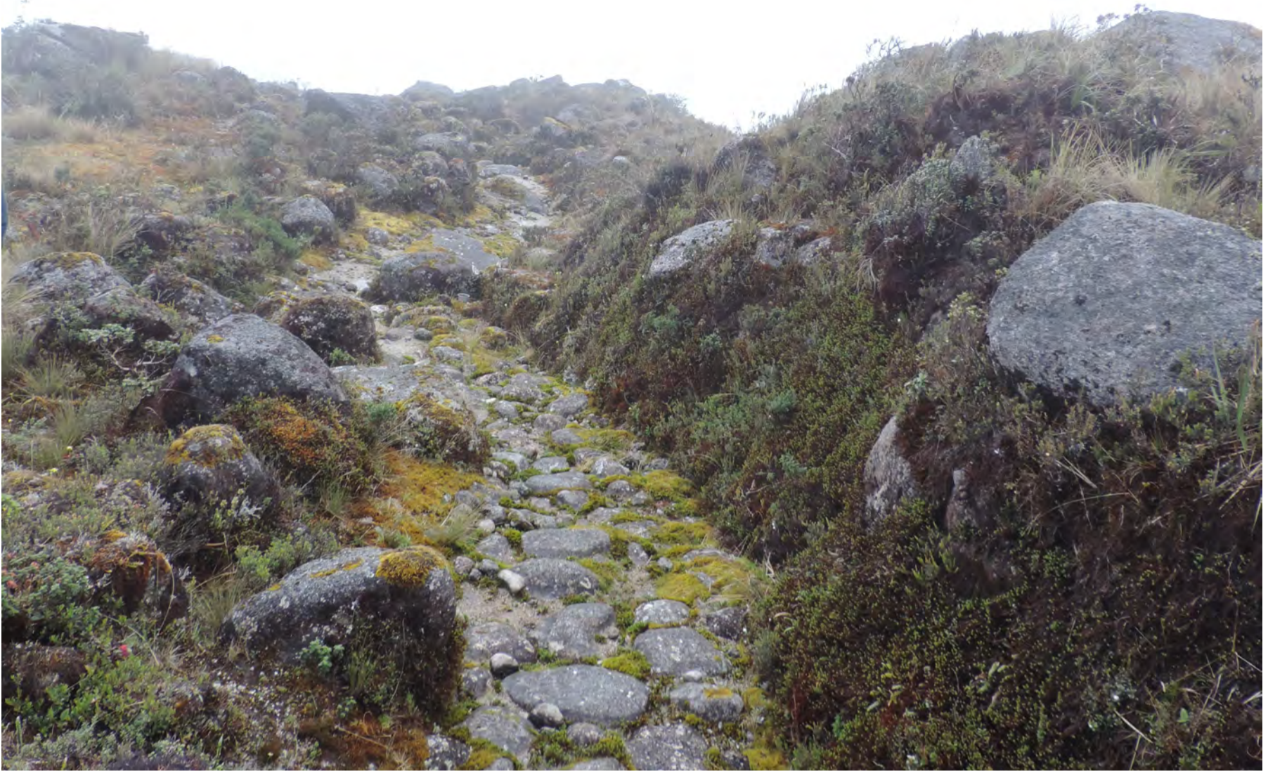
Figura 103 Vista del camino empedrado delimitado por monolitos y cortes de talud lateral.
