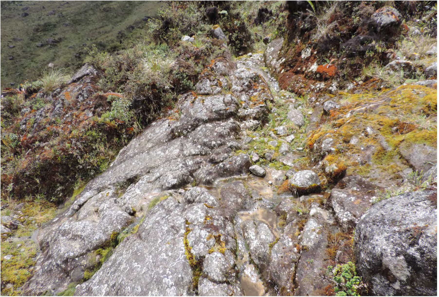
Figura 143 Canal de agua excavado en la roca natural cruza el camino.
