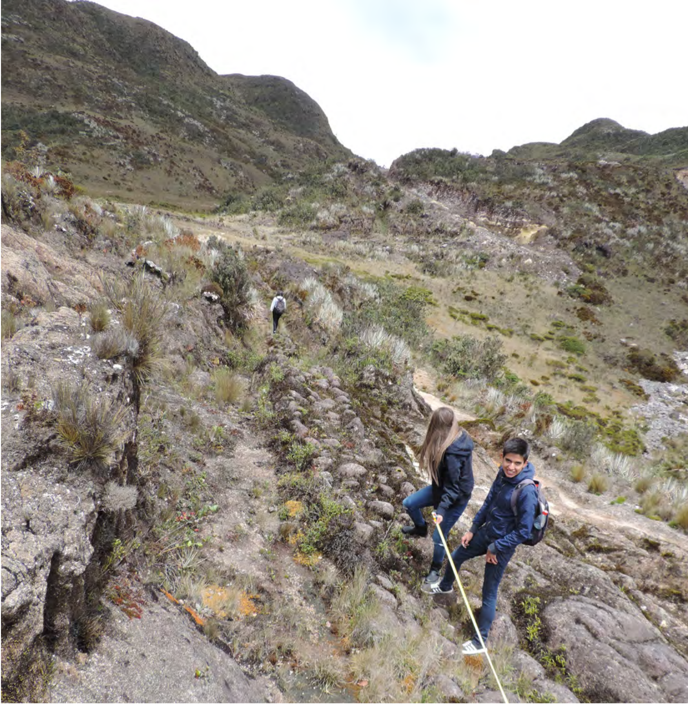
Figura 45 Calzada empedrada y corte de talud lateral en piedra.
