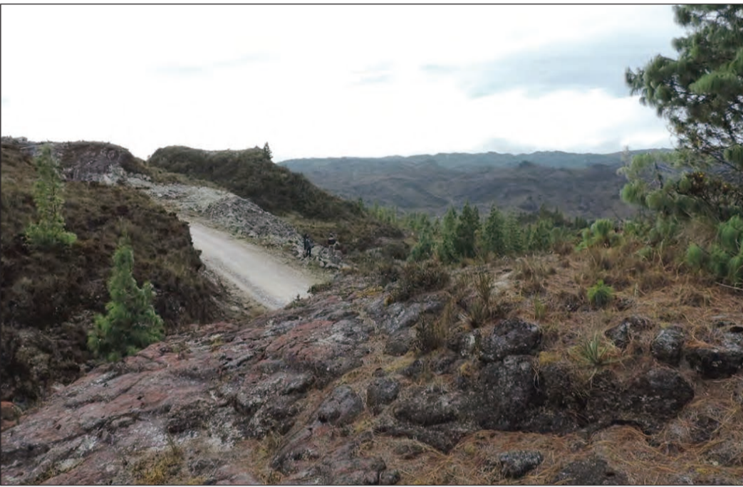
Figura 10 Vista desde el Qhapaq Ñan de un segmento del camino cortado por la carretera
