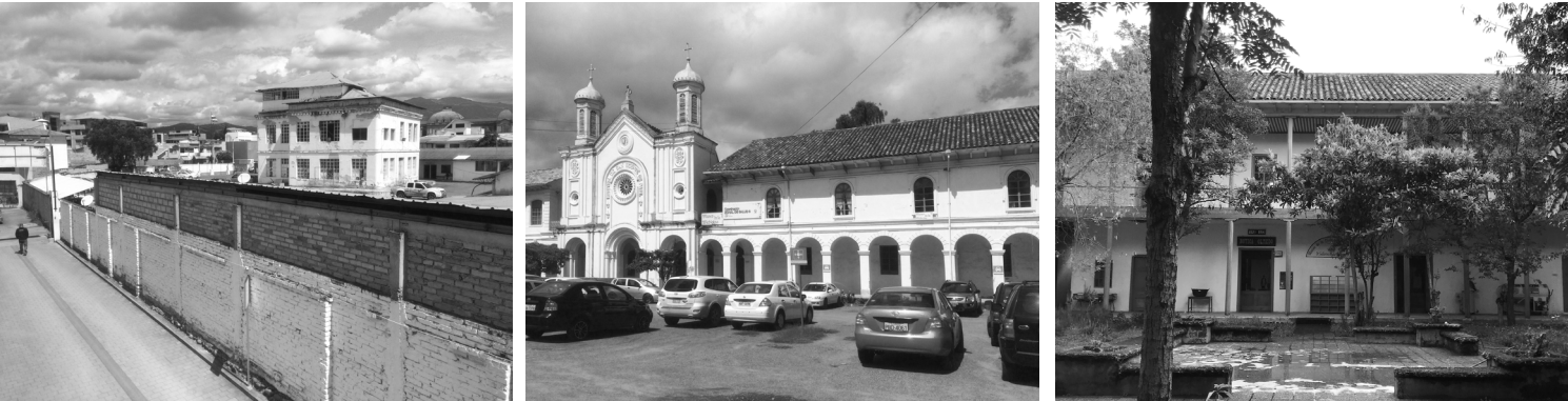
1. Edificio del GOE
