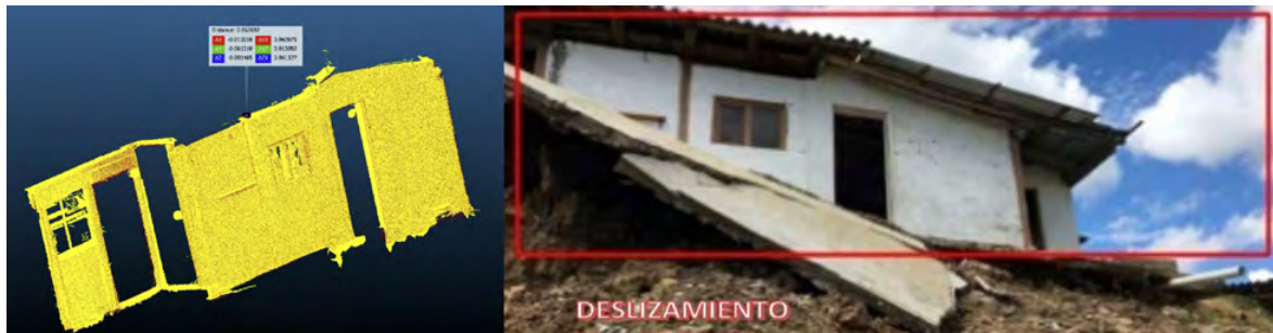
Figura 3: (Izquierda) Pared cercana al deslizamiento, en rojo: escaneo de mayo y en amarillo: escaneo de junio, (derecha) pared en campo.
