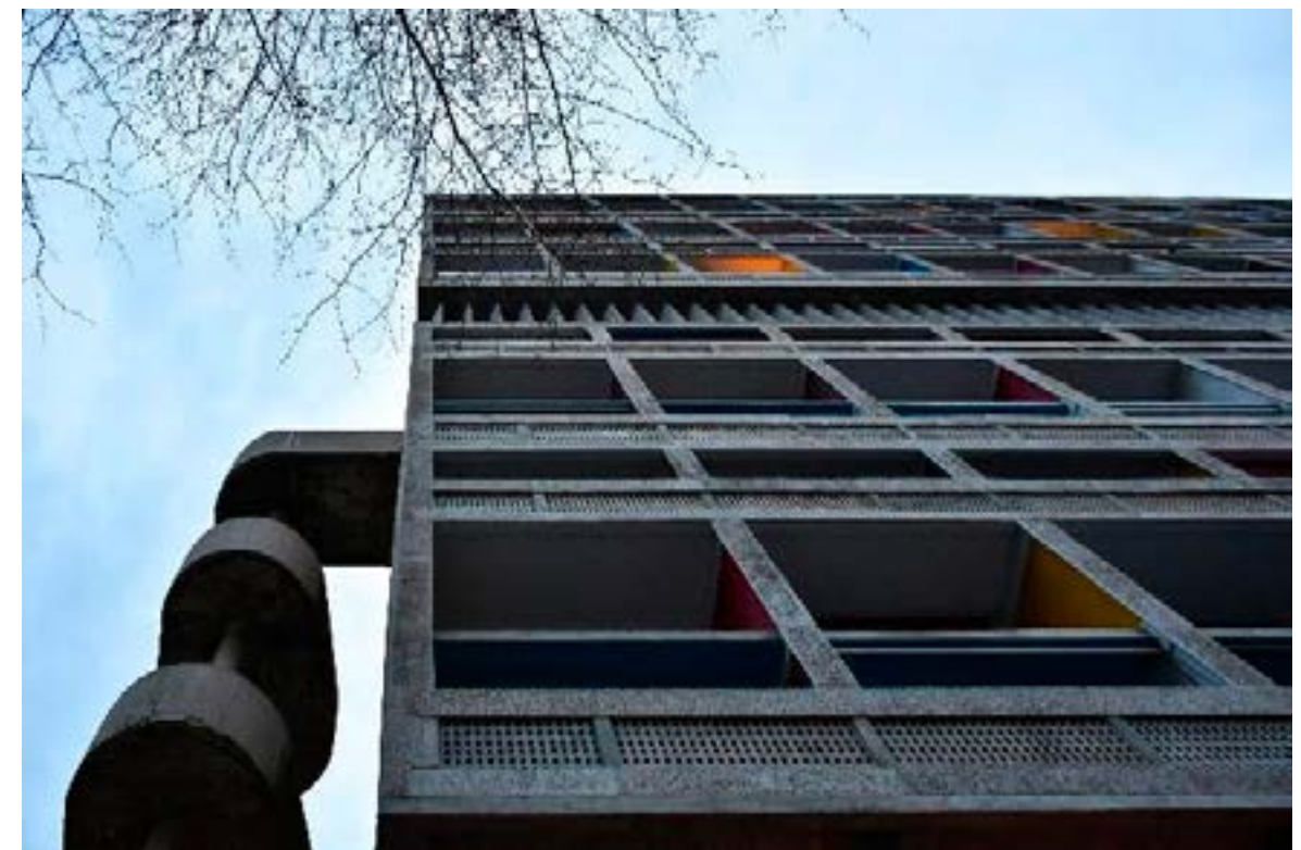
Figura 2. Vista exterior, escaleras hacia los servicios. Elaboración propia.
