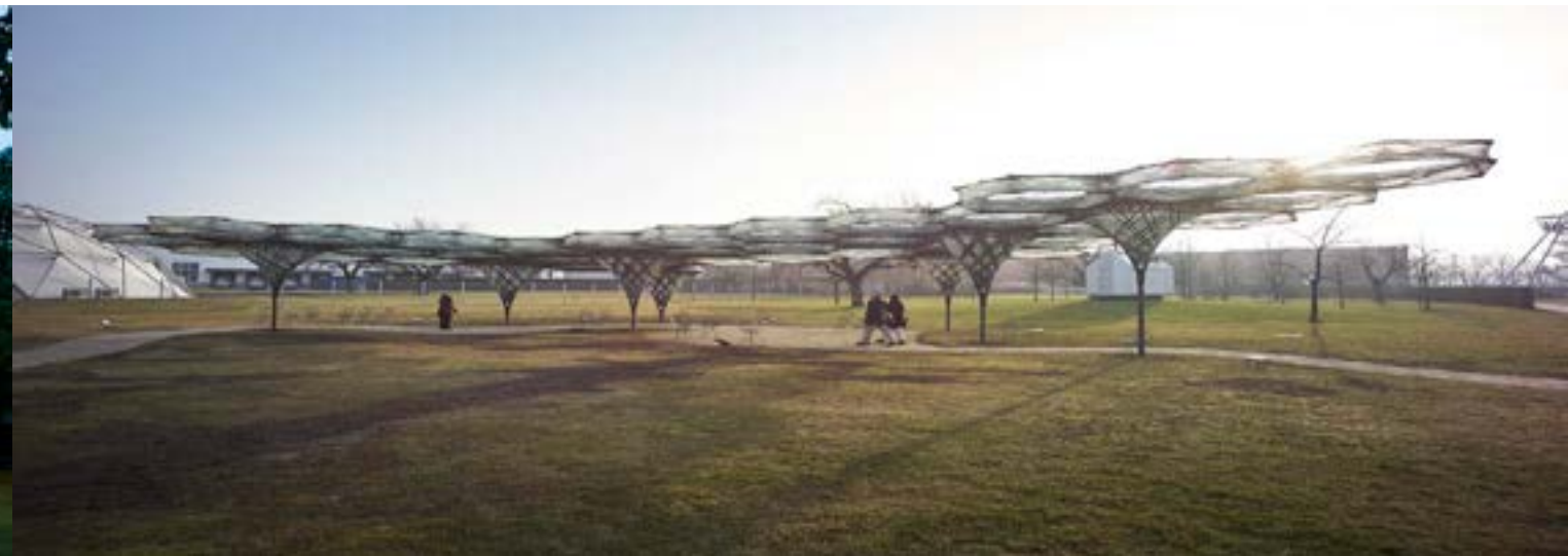
Figura 3: Elytra Filament Pavilion. Diseñado por Achim Menges y Moritz Dörstelmann Fuente: Menges, A. (2017).
