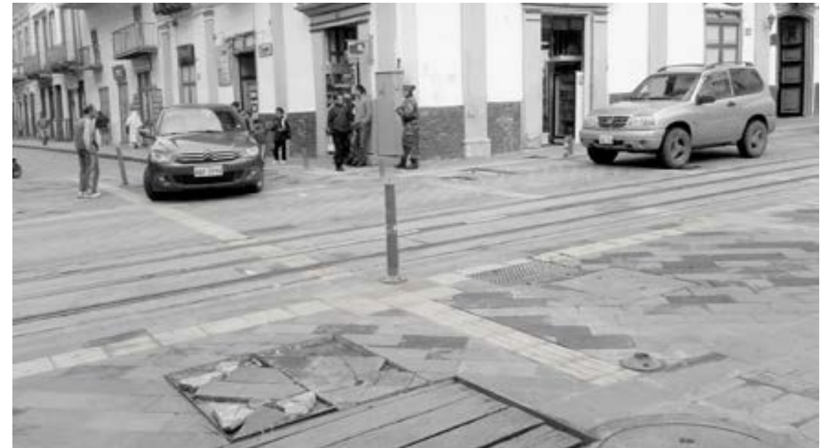
Figura 10. Color y material de las bandas podotáctiles sin distinción (calle Gran Colombia) Elaboración propia
