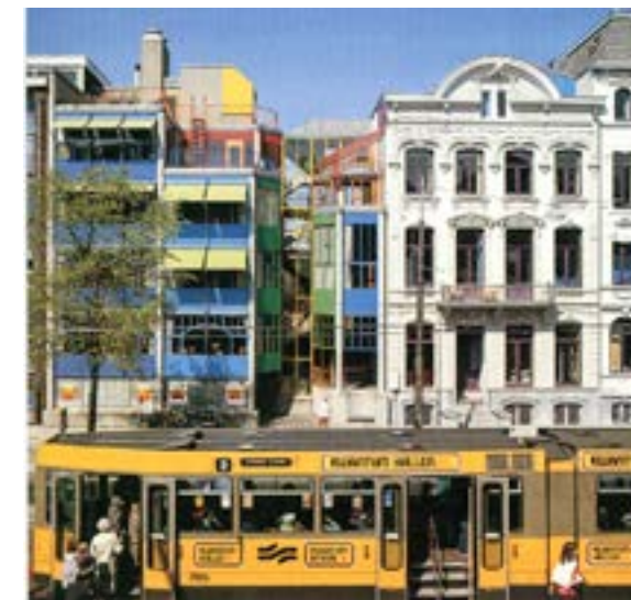
Figura 8. Vista frontal de la Vivienda Hubertus, Fuente: Van Eyck (1999)
