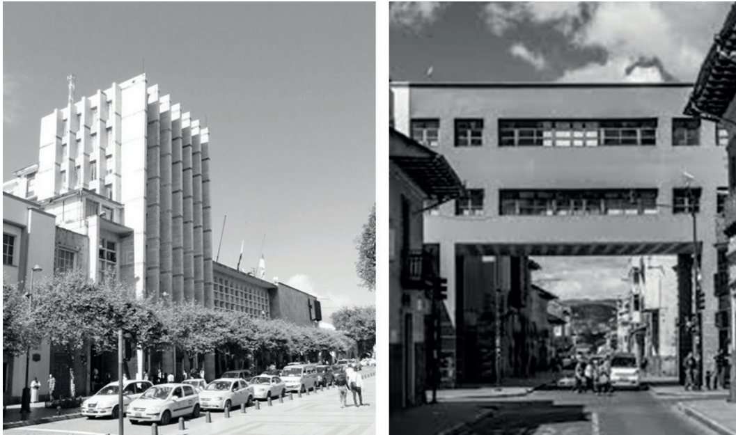
Figura 2. Edificios de la Casa de la Cultura y Palacio Municipal, Gilberto Gatto Sobral
