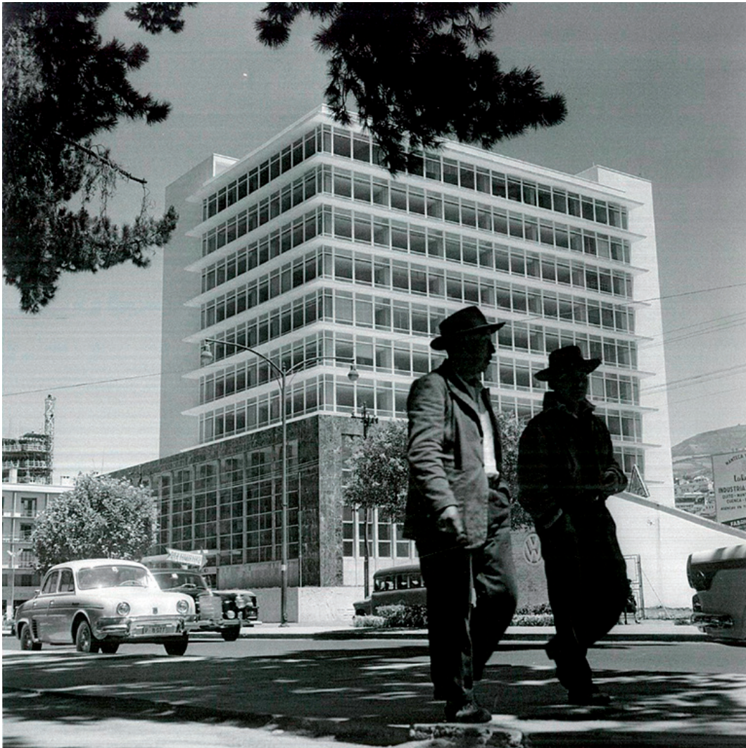
Figura 2. Edificio de la Caja del Seguro Social
