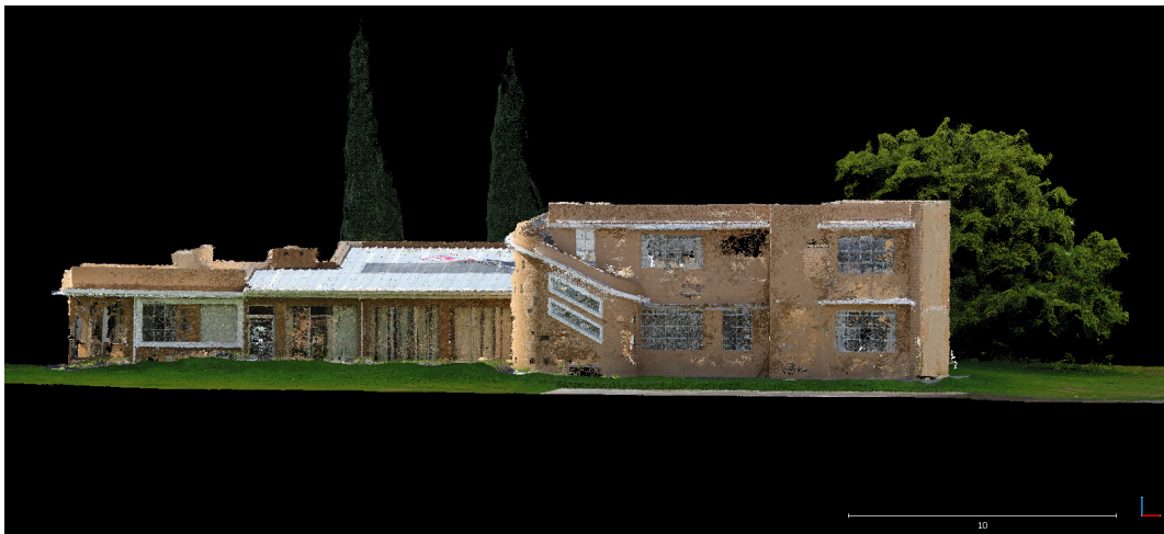
Figura 4. Fachada posterior del caso estudio relevamiento mediante fotogrametría
