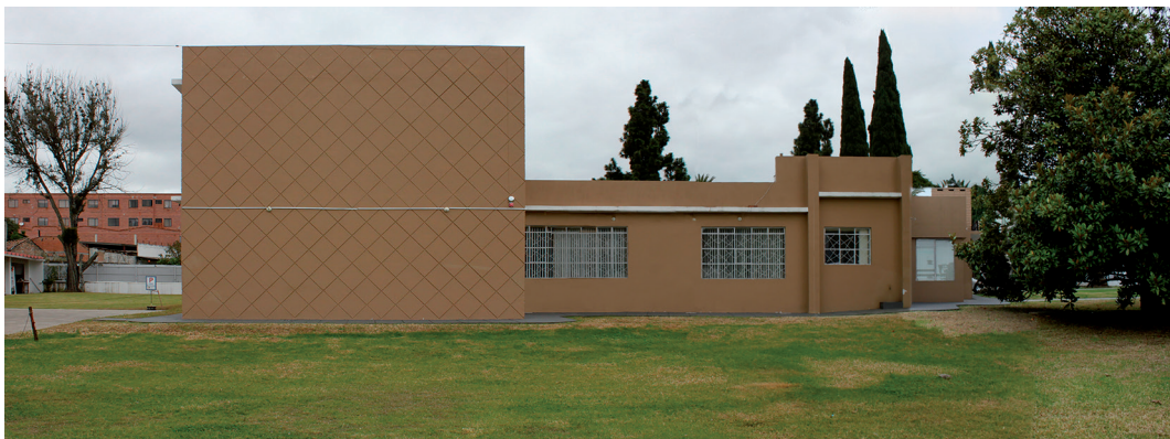
Figura 6. Fachada lateral izquierda del caso estudio relevamiento mediante fotografía rectificadas
